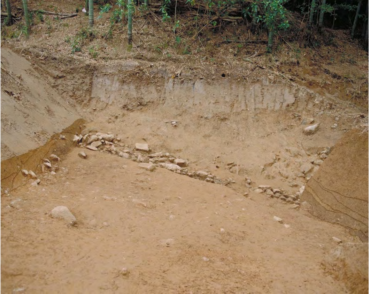
pla.42 谷地形傾斜状況(北から)
