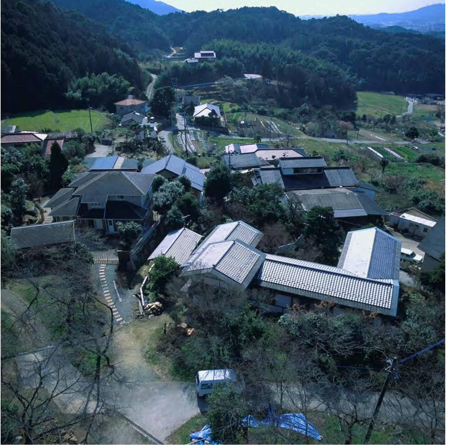
pla.65 空中写真 現場より大門を望む(北から)
