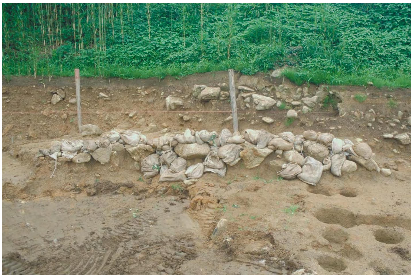
pla.23 40SX015 埋め戻し前、養生（西から）
