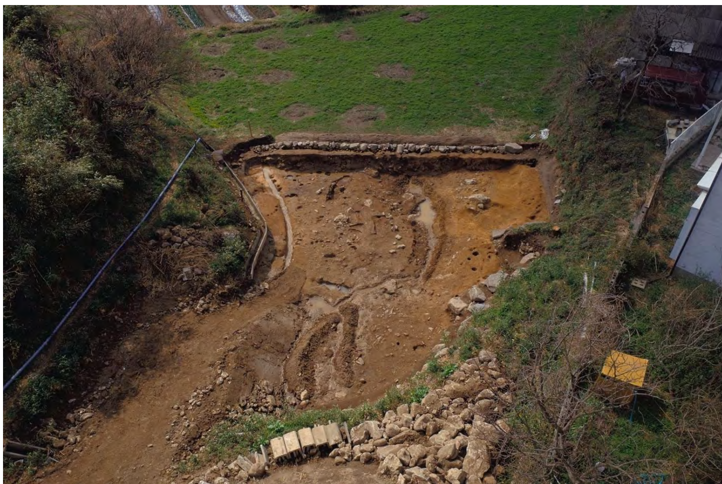
pla.18 第2調査面完掘状況（北から）
