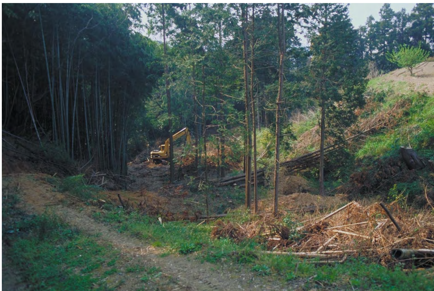
pla.55 表土めくり（東から）
