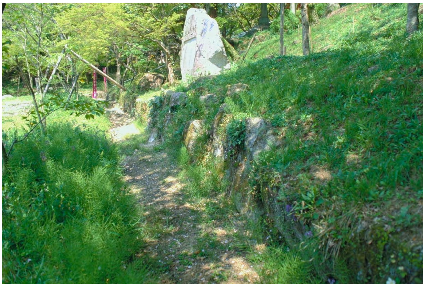
pla.74 調査区外 東部現況石列(南から)
