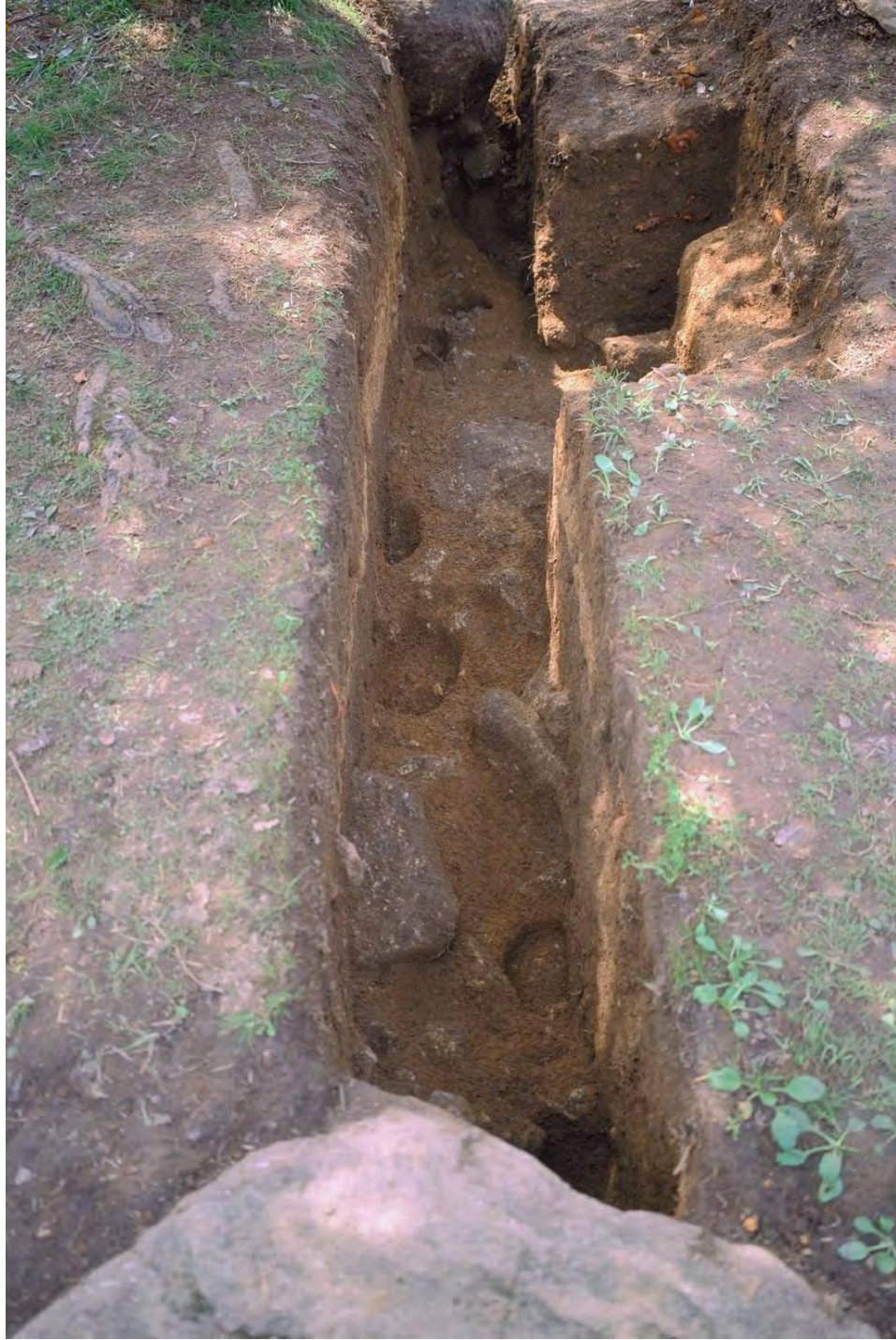
pla.52 14 トレンチ 完掘状況 (東から)
