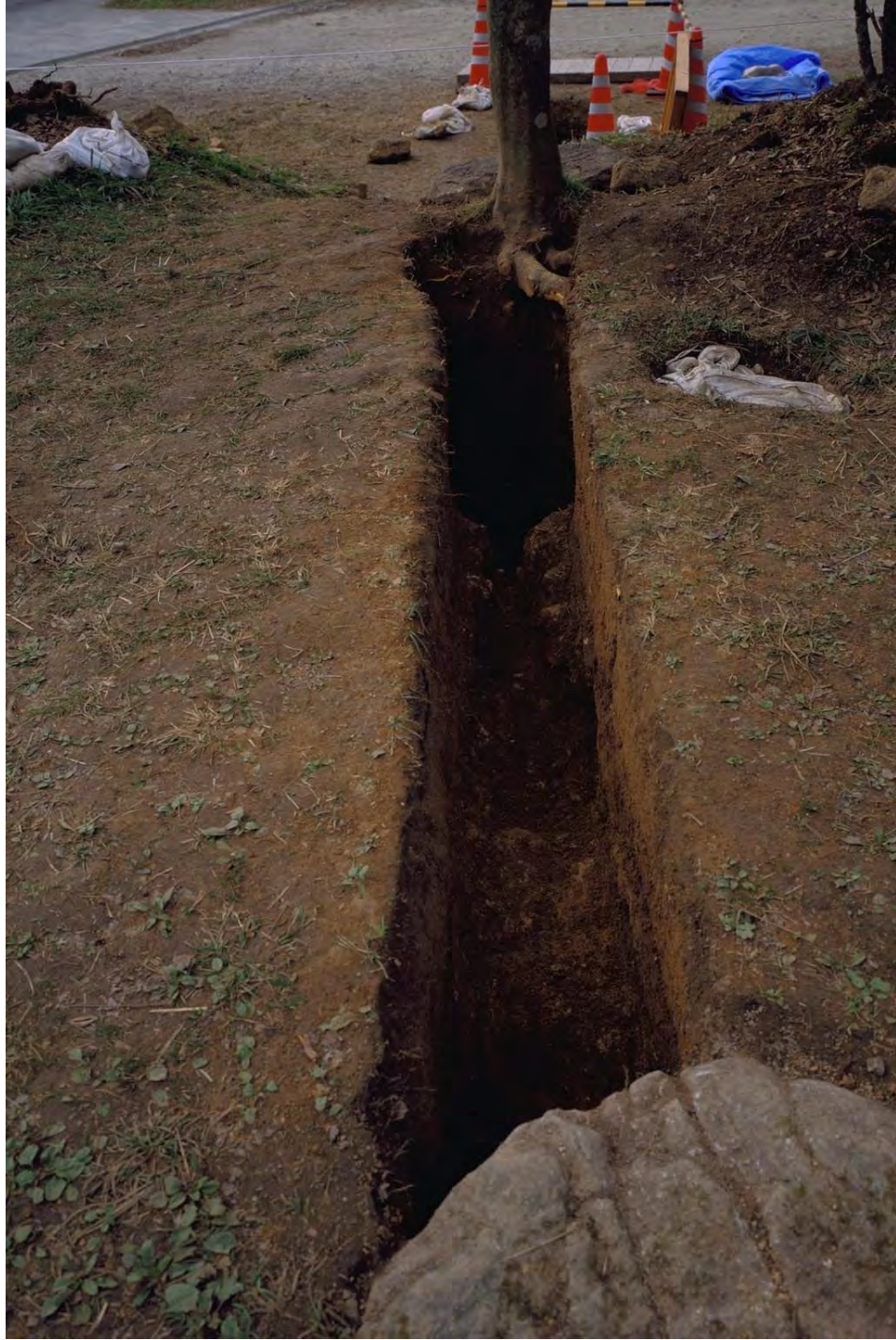
pla.56 15 トレンチ 完掘状況 (東から)
