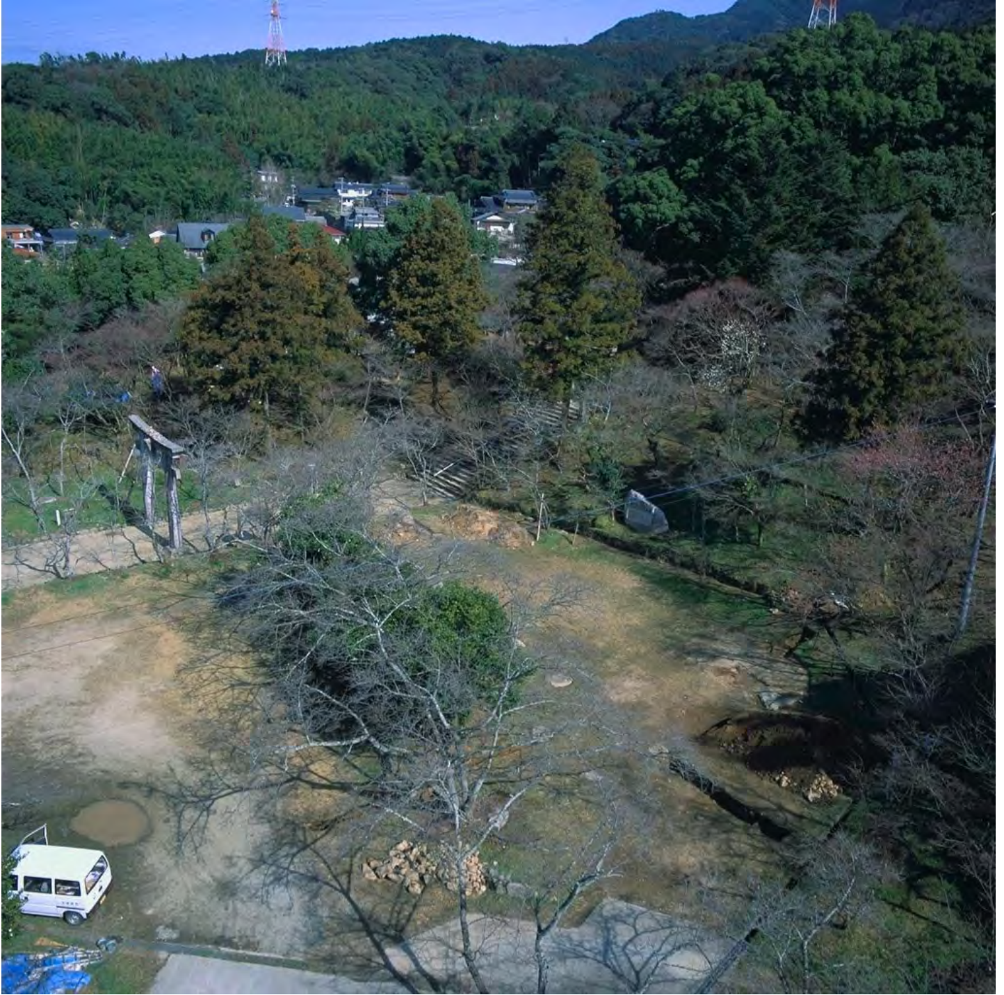
pla.61 空中写真 調査区全景(南から)
