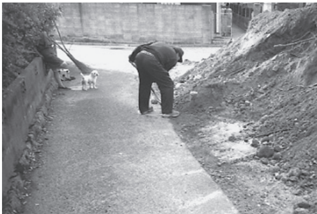
写真6. 立会調査状況（東から）
