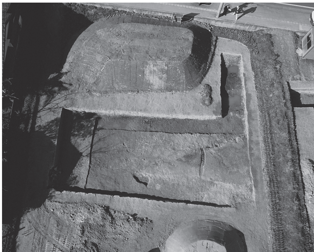
26次調査 西調査区全景（南から）
