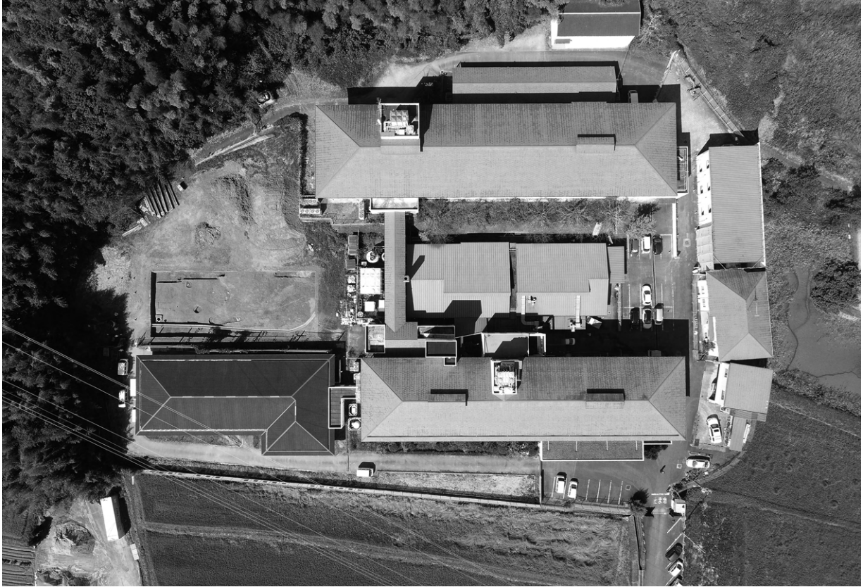
調査区全景空中写真（上が北）
