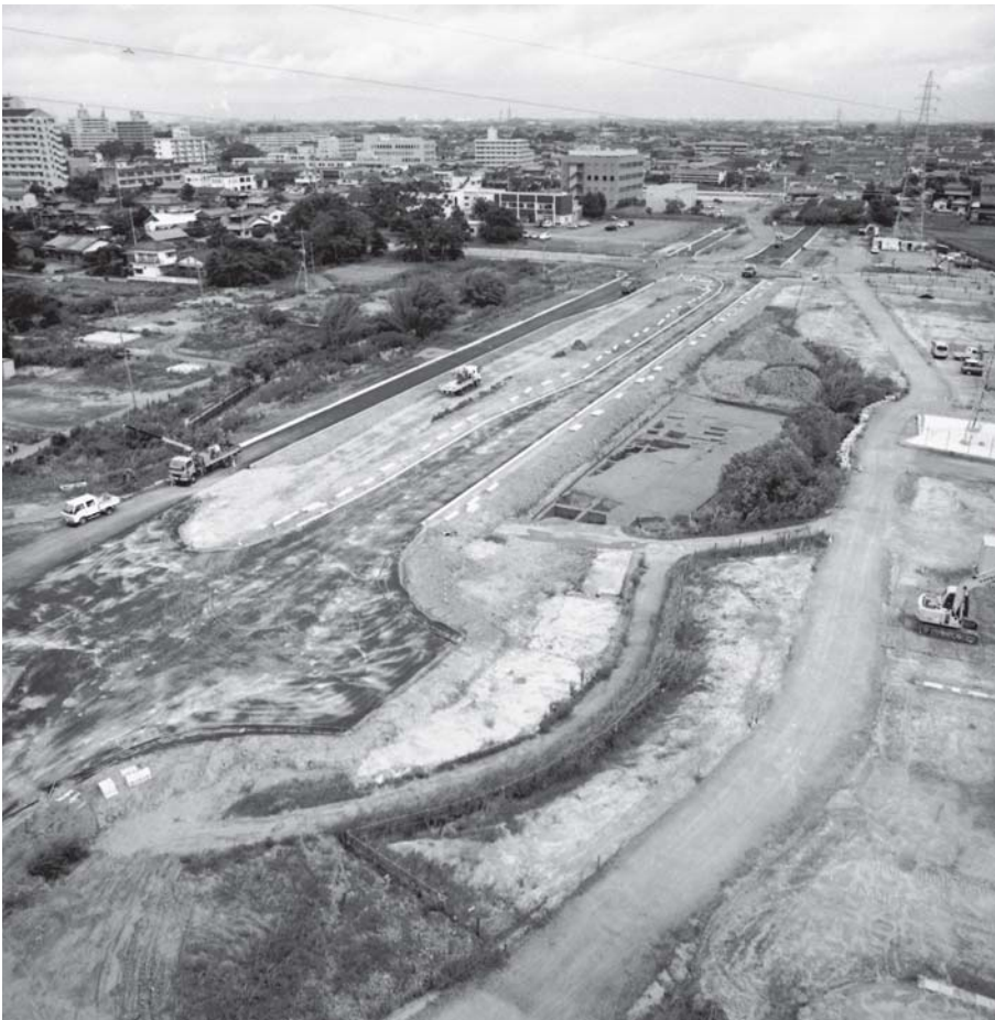
1. 蒲船津西ノ内遺跡第2次調査区 (航空写真・北から)
