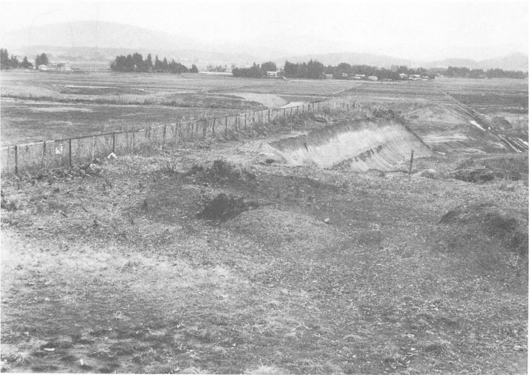
図20-1 5号現況(南西から)
