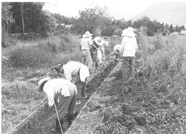
トレンチ掘り
