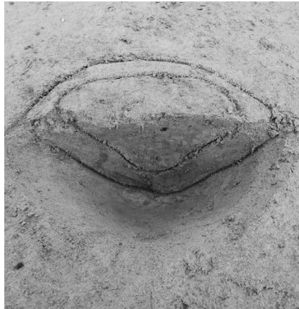
(8) SA 1-SP63 土層断面 (南西から)
