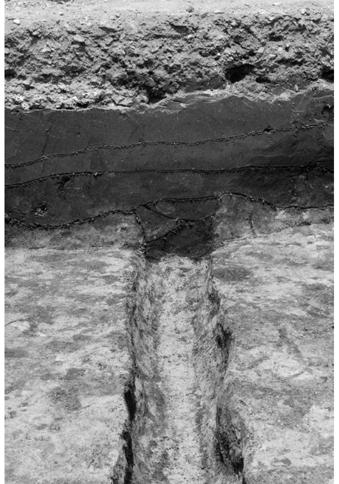
2. 2区25号溝全景土層断面A-A'(南東から)
