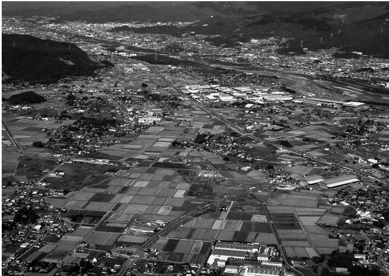
1 猿楽遺跡遠景（上空南側より）
