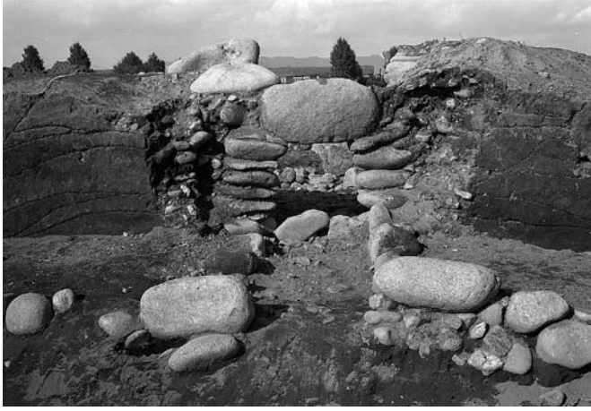
1 1号墳玄門部分石積検出状況（南西から）
