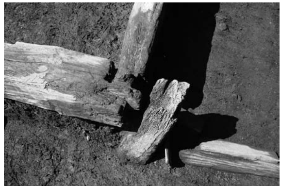
5号建物1号床 北側掘立柱・大引・根太の接合 北東→
