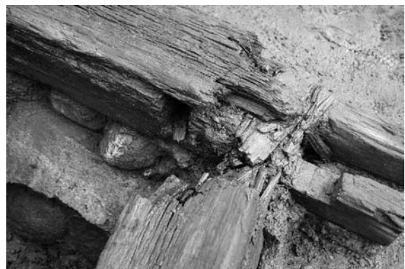
1号建物室 南西隅枠の仕口 北西→
