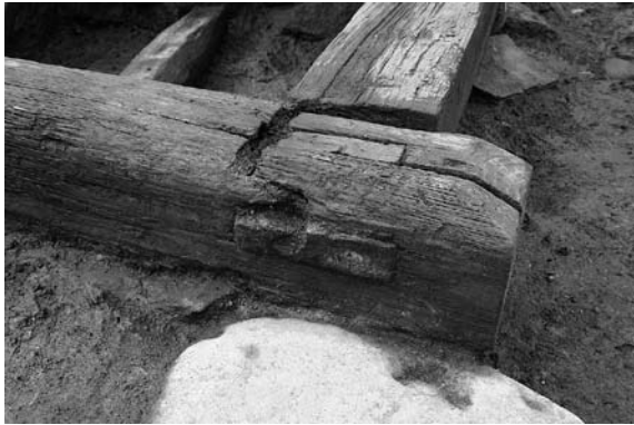
1号建物室 南東隅枠の仕口 南東→
