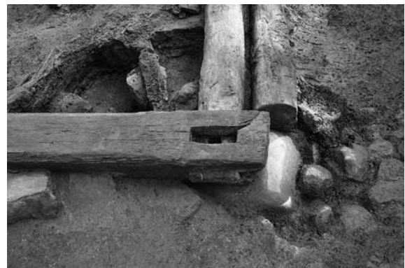
2号建物 南西隅土台・柱接合の様子 西→
