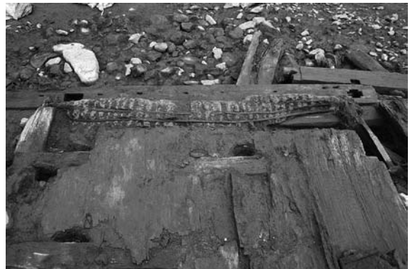
4号建物 北側土台上に遺存した土壁の一部 南→
