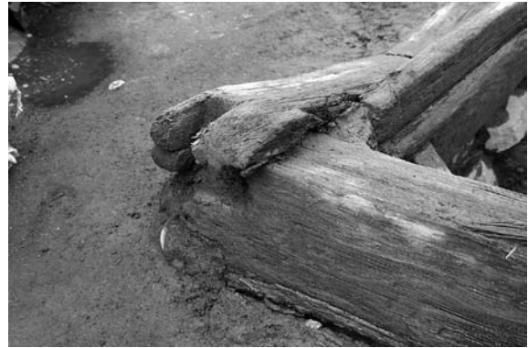
1号建物室 北西隅枠の仕口 南西→
