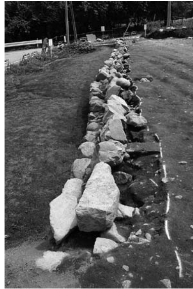
4号石垣 上部構造と掘込プランの様子 北→
