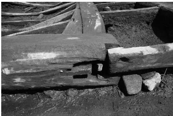
1号建物3号床 西大引(No.75・76)の接合の様子 西→
