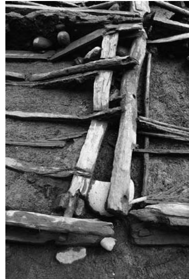
5号建物3・4号床 境界部礎石・掘立柱・大引・根太 北→
