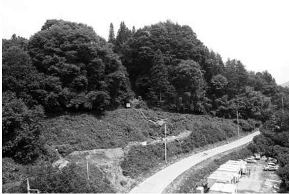
19号トレンチ遠景① 南西→
