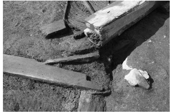
2号建物 北西隅礎石・土台接合の様子 東→
