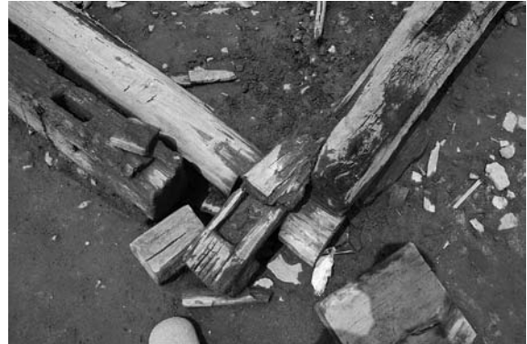
4号建物 南東隅土台仕口の様子 南東→
