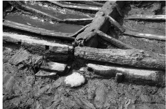
5号建物2号床 南側地覆・大引・根太の様子 南東→
