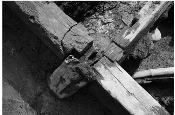
5号建物1号床 東側掘立柱・大引・根太の接合 北東→
