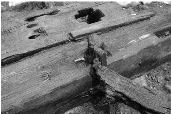
4号建物 北側土台・柱接合の様子 南→
