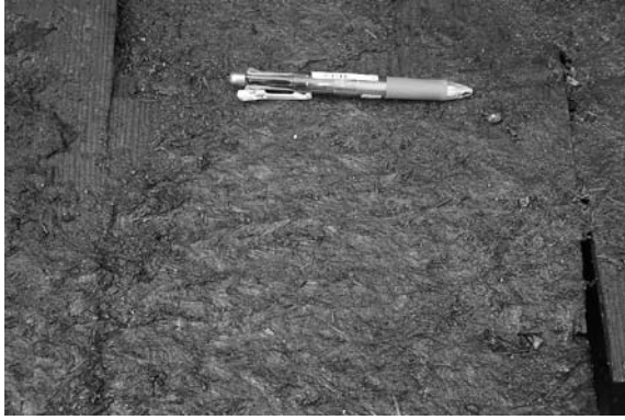
5号建物1号床 榫の様子① 近接
