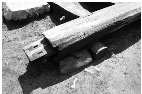
1号建物3号床 北東隅礎石・束・大引の様子 北東→
