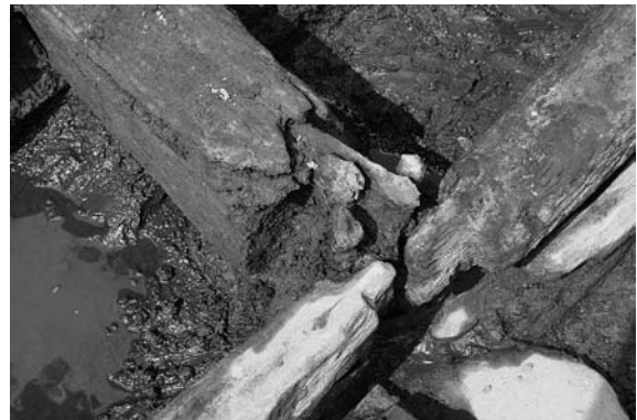
5号建物2号床 南側掘立柱・大引接合の様子 南西→
