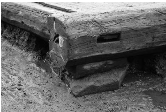
1号建物3号床 北西隅礎石・束・大引の接合 北西→
