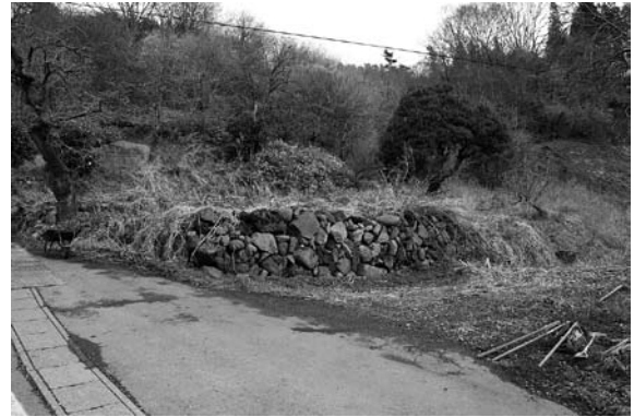
3号屋敷跡調査前状況 南→
