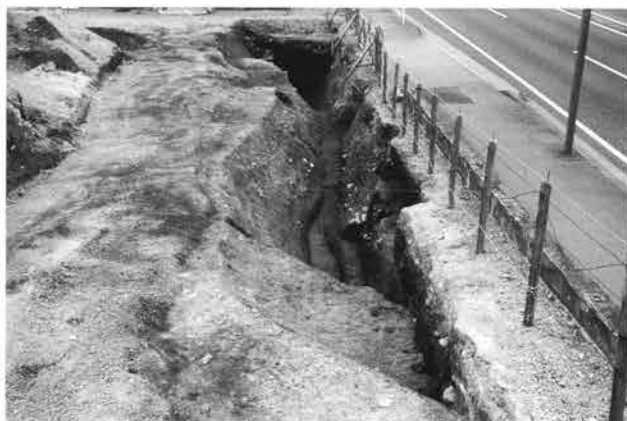
1号（本丸西側）堀全景（南から）
