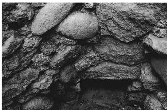
1号炭窯側面（煙道入口、東より）
