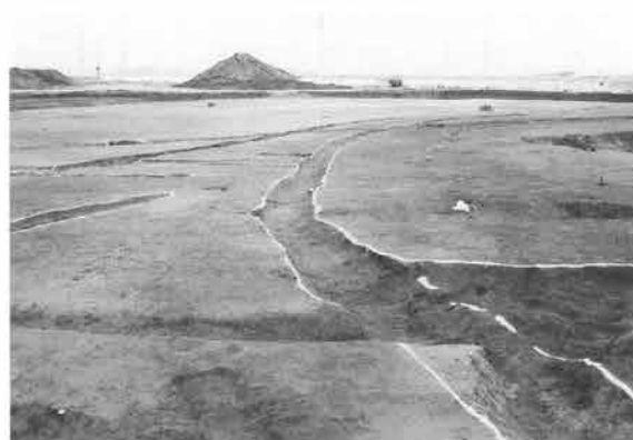
8-2-62・63・65・67号溝 (北西より)
