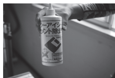
セメント除去剤を用いてモルタルを除去する
