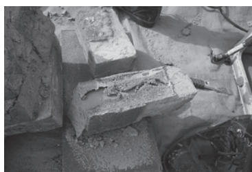
分解後の煉瓦 モルタルを節約し中央が空いている
