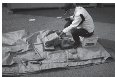
平たがねやハンマーを用いて煉瓦毎に分解する
