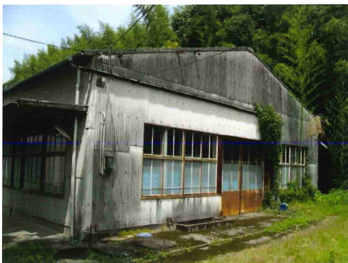
旧埋蔵文化財センター 収蔵庫外観
