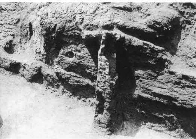
d. 同上・壁面際に打設された板材を固定する杭
