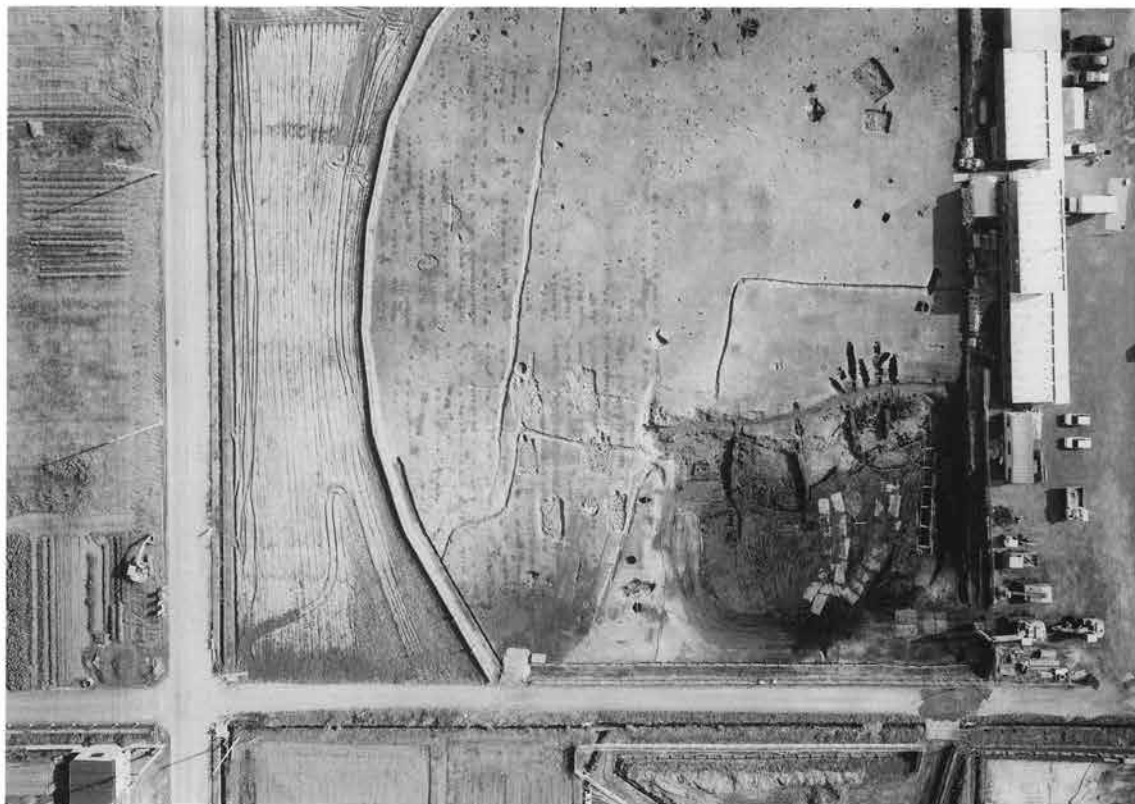
A区全景 (上が東)
