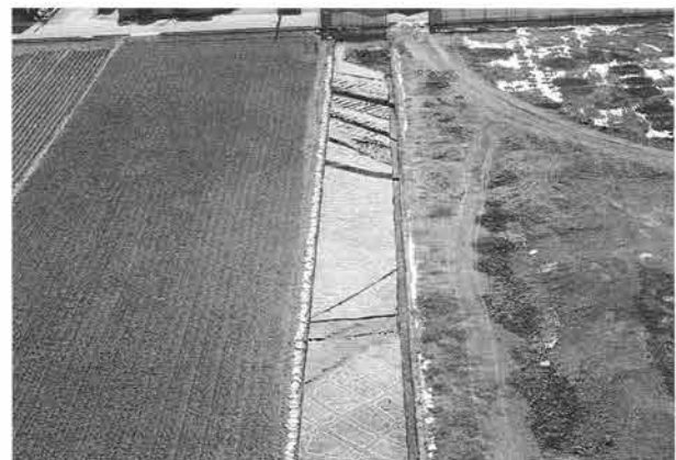
8 取付道A区Hr-F下水田(北から)
