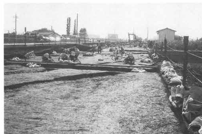
鳥山下9区調査風景（北より）
