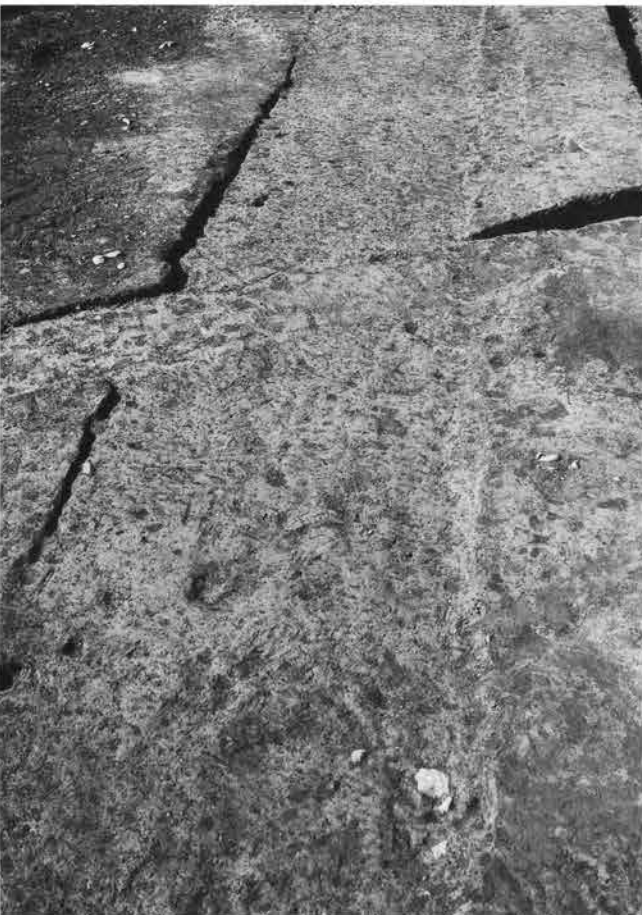
鳥山下10区111号溝全景 (東より)
