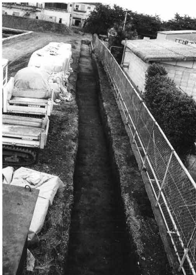
Dトレンチ全景 (西から)
