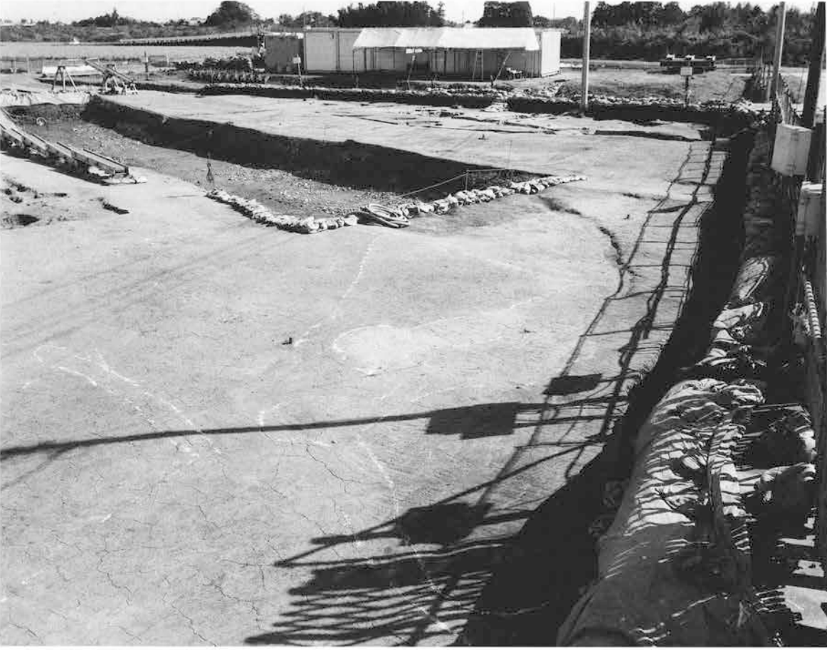
▲C区2面 全景7 北西から
