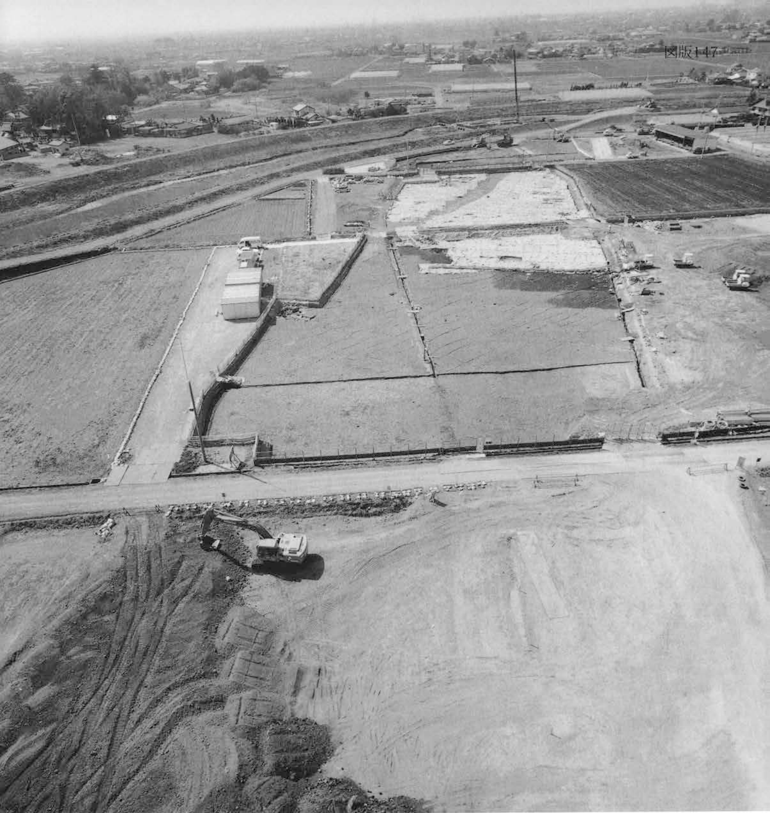
D区4面 東20m シルト層上面1 東上空から
