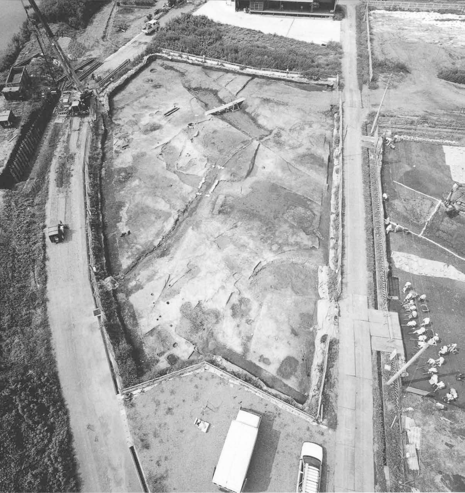
B1区4面 全景1 南上空から
