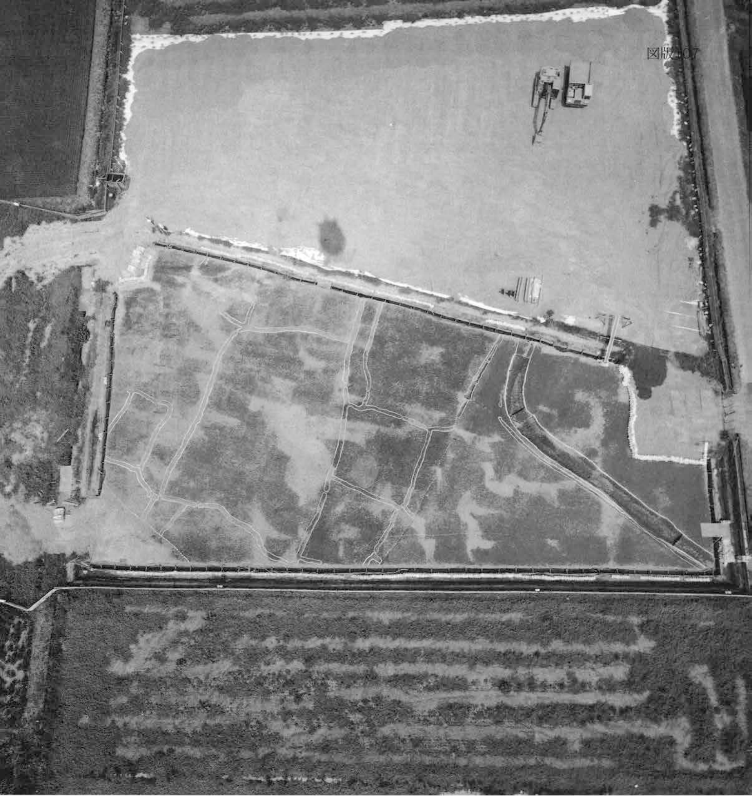
D区1面 As-B下水田 全景1 南上空から
