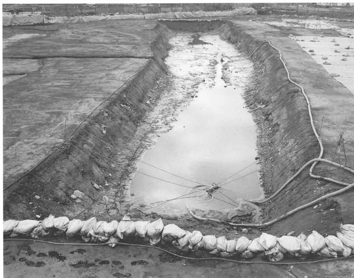
▼C区2面 142溝 全景 南東から
