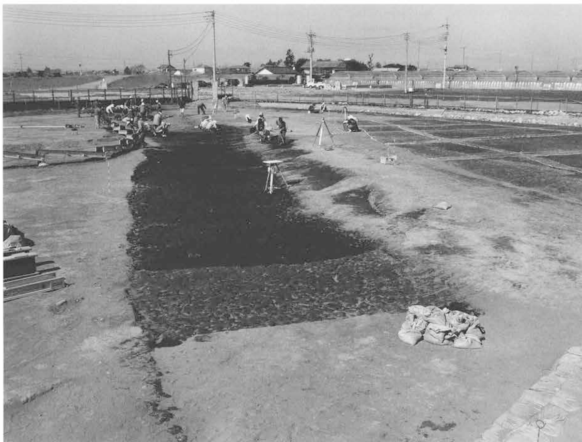
▲C区1面 全景3 31溝 南東から
