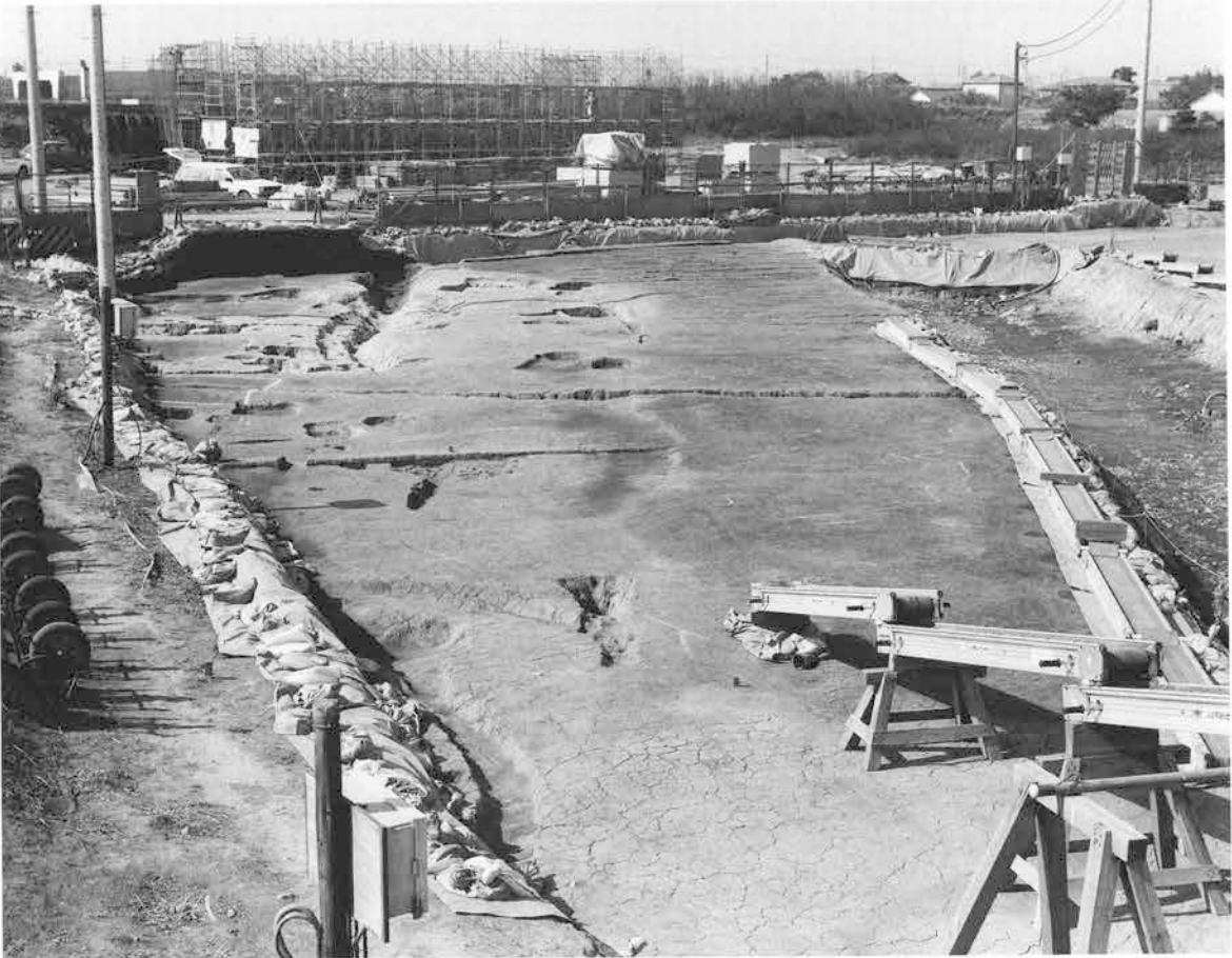
▲C区2面 全景3 142溝南側 東から
