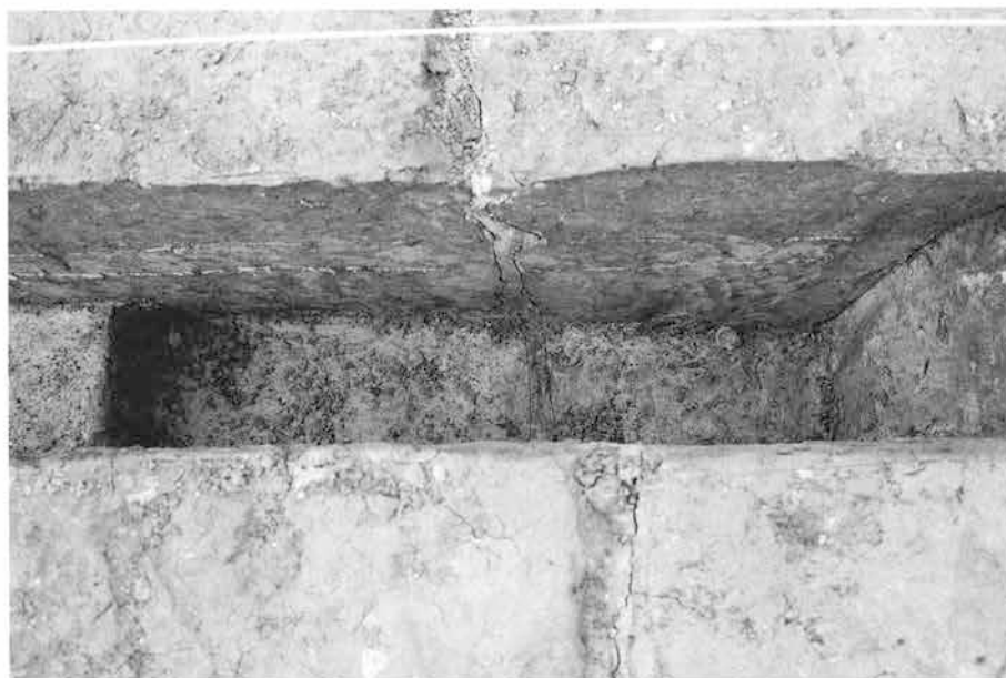
E区3面 3トレンチ 噴砂 東から
