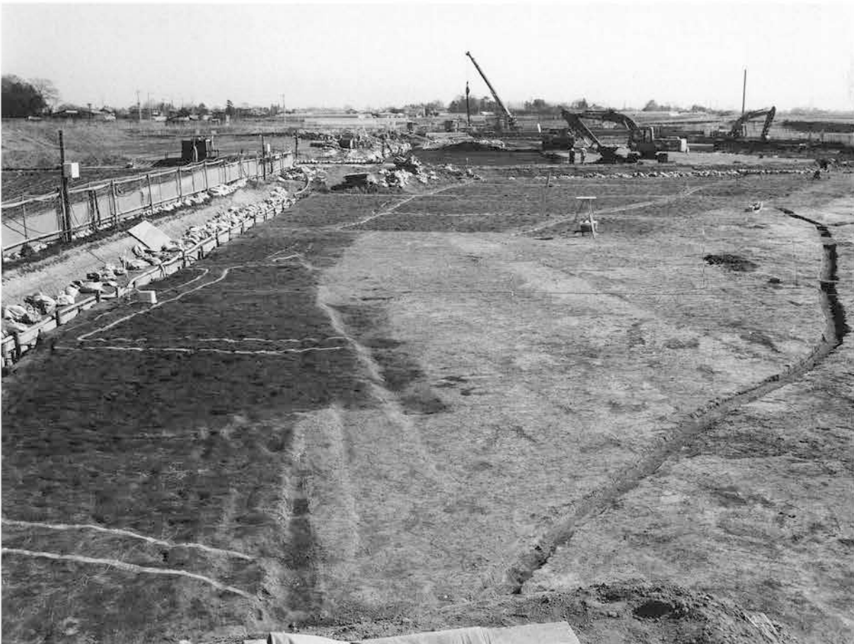
▼C区1面 全景2 北西から
