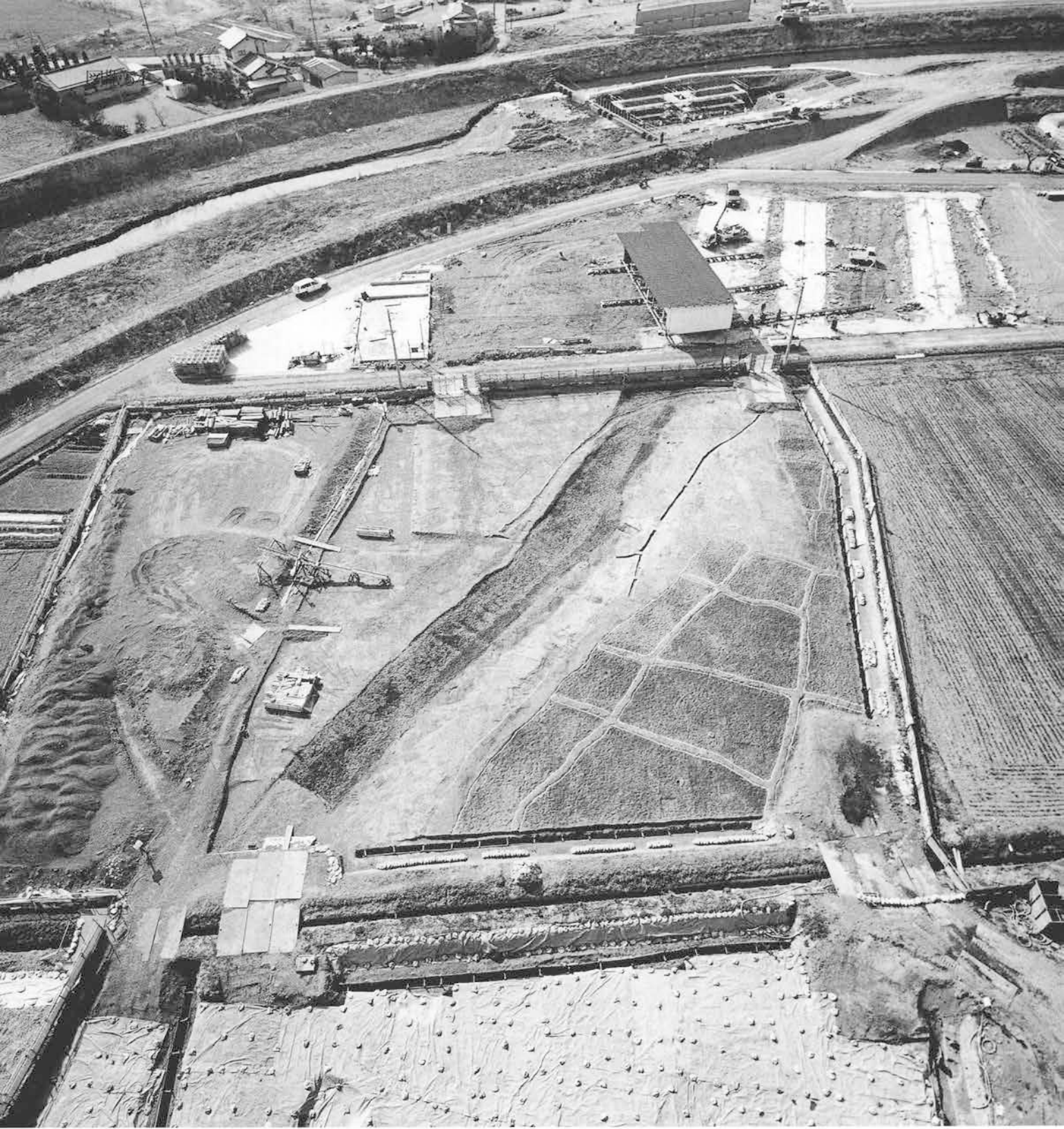
C区1面 As-B下水田 全景 東上空から
