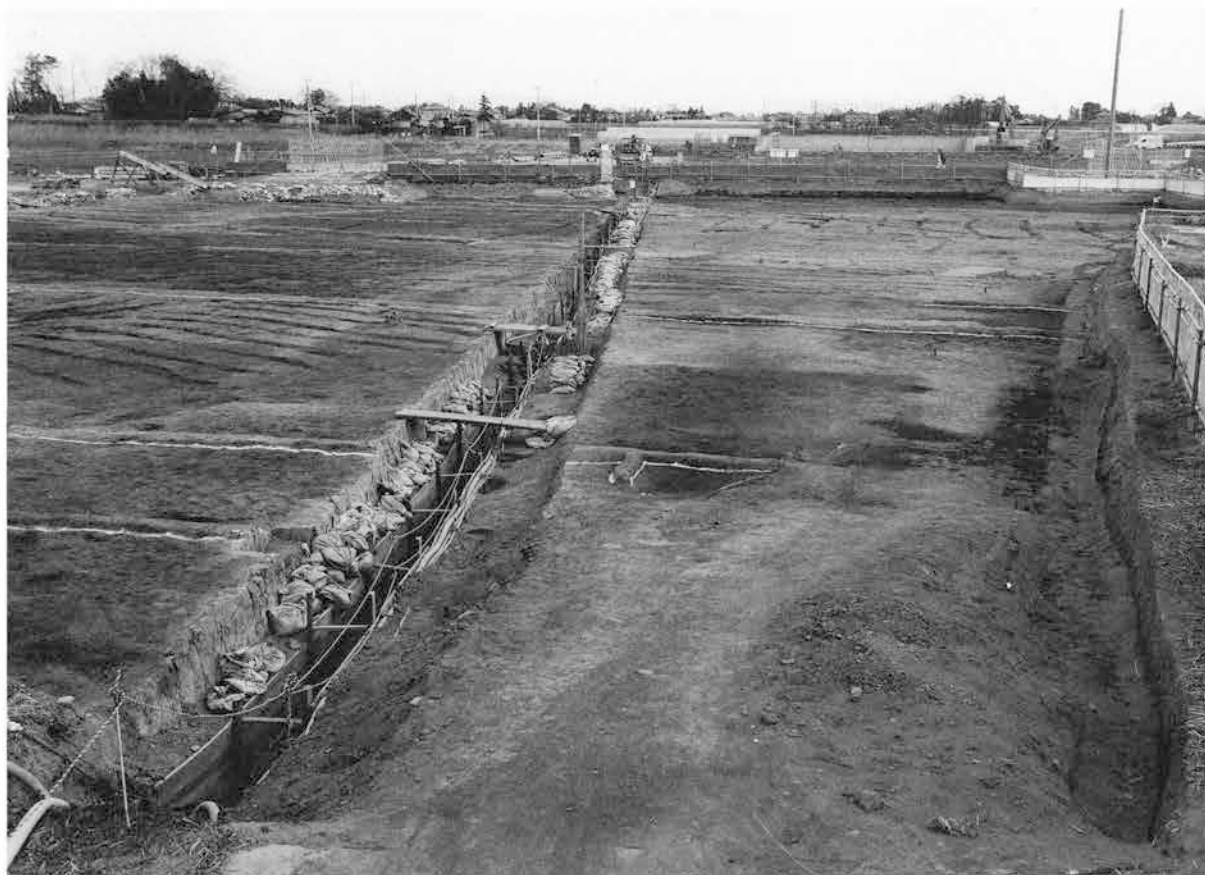
▲D区2面 洪水層下水田 全景2 西から
