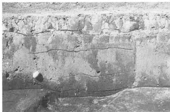
2. A 3区2面 28号溝土層断面 (南から)
