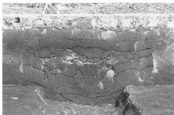
4. A 3区2面 29号溝土層断面 (南から)
