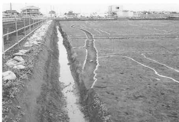
4-1-2号溝全景（東より）04-00057-05
