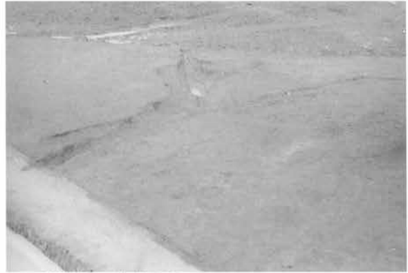
2-2-2号溝全景（南東より）04-00070-04
