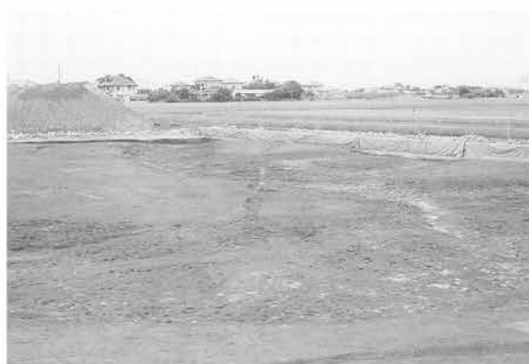
2-2-北西部全景（東より）04-00070-01
