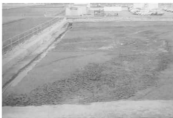
2-2-北部全景（西より）04-00069-01
