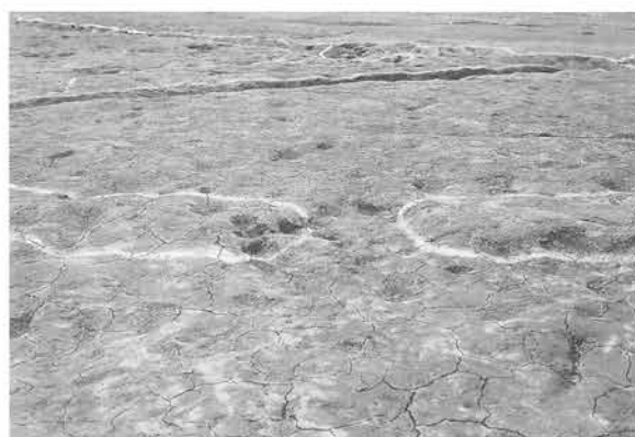
2-1-As-B中東部北西水口（北より）04-0036-02
