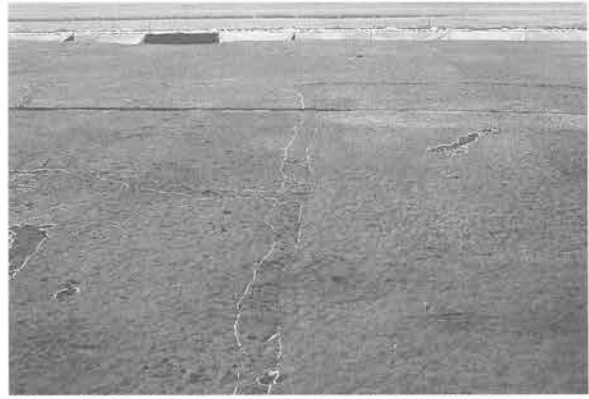
2-1-As-B下水田水田面北部（南より）04-00047-09
