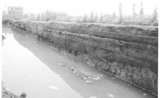
K区南壁（北西から）
