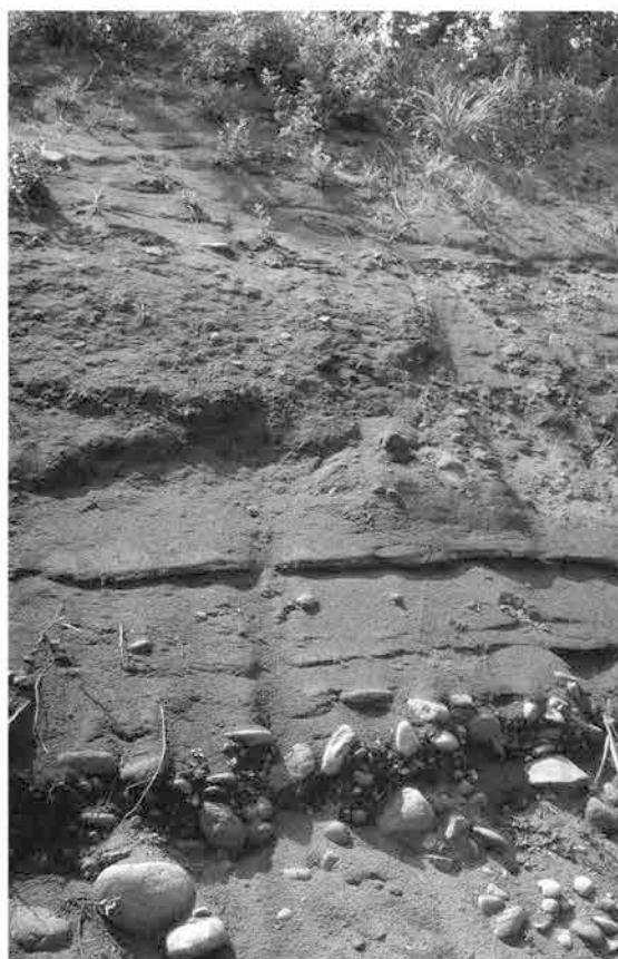
利根川左岸土層断面（東から）
