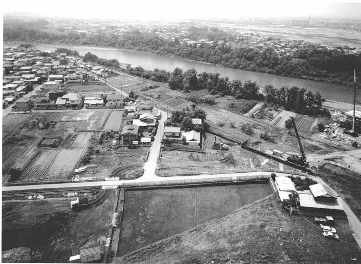
全景および周辺の景観（利根川を臨む、北から）
