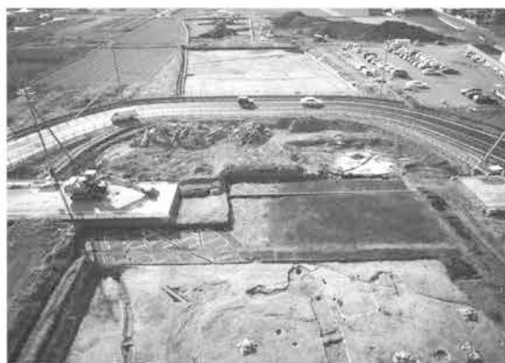
現道下全景(東から)
