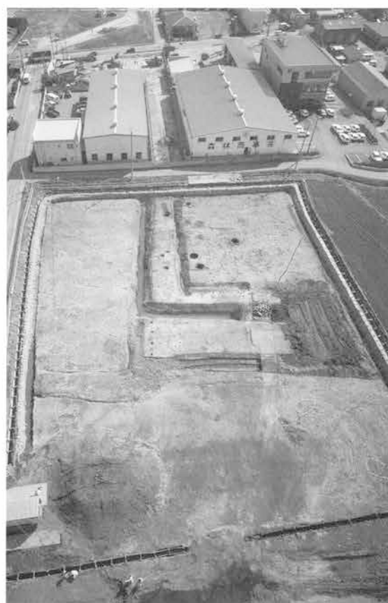
L区（東）全景（西から）
