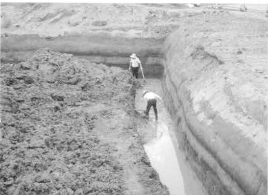
調査風景 (東から)
