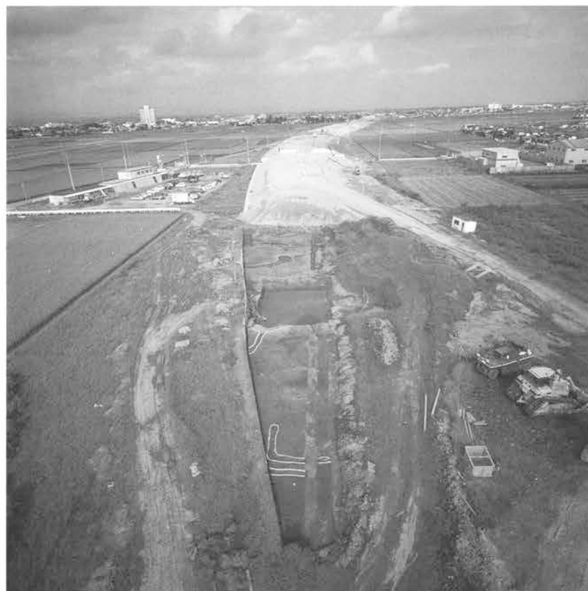
B区（北）全景（西から）
