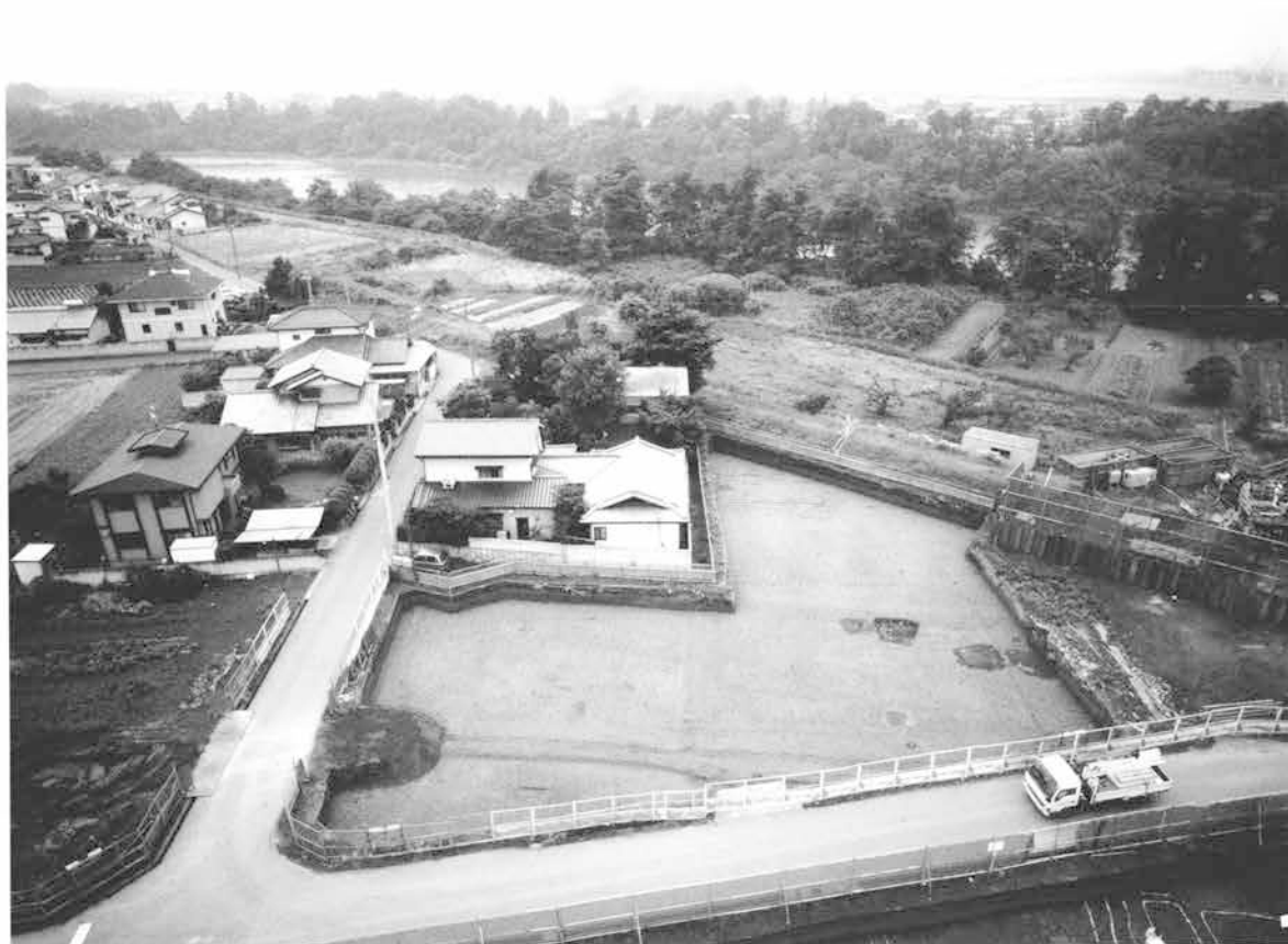
全景 (後方は利根川、北から)
