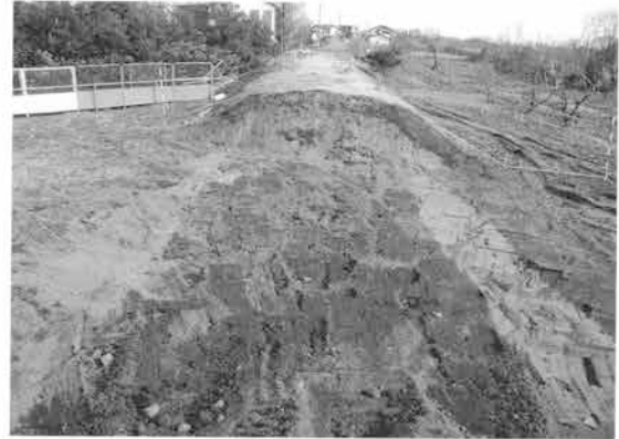
堤防下面（西から）
