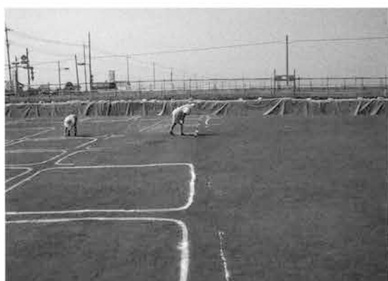
確認状況（南から）
