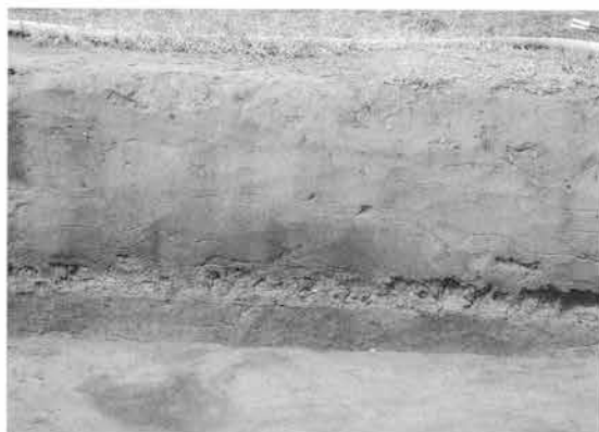
北壁（第5面南北大睦畔付近、南から）
