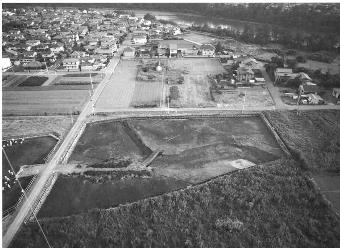
A区1号流路・As-C下面（北から、上方が現利根川）
