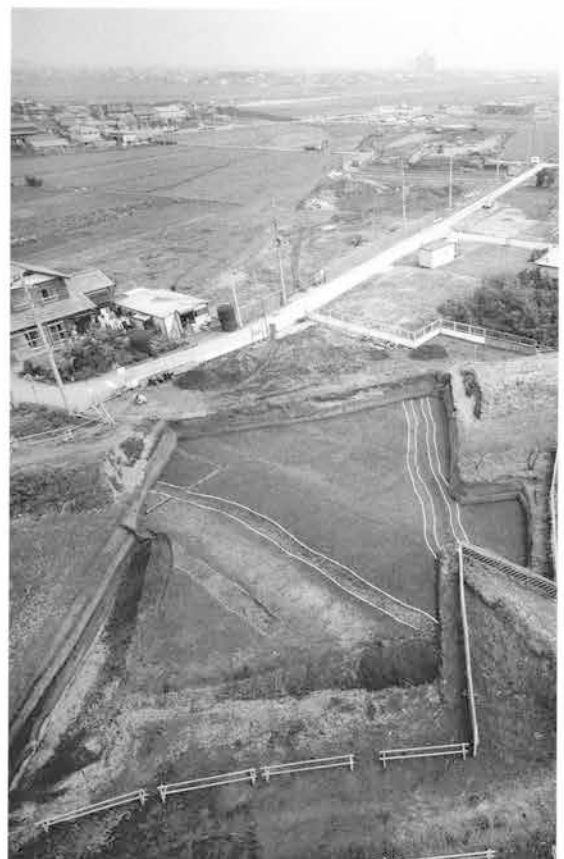
全景および周辺の景観（西から）
