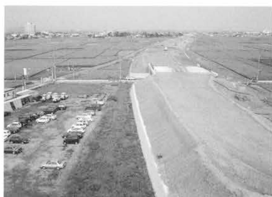
C区以東調査終了地点（西から）
