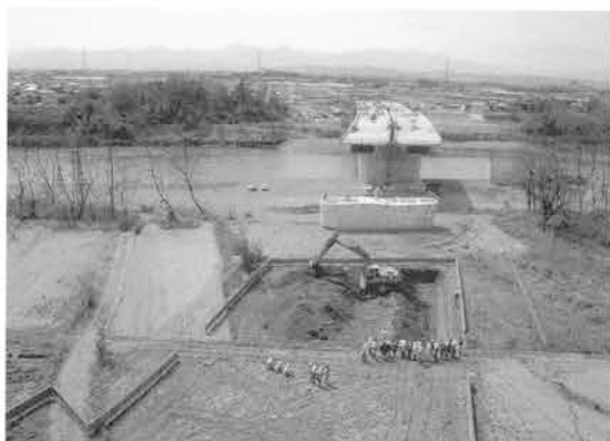
試掘調査風景（東から）
