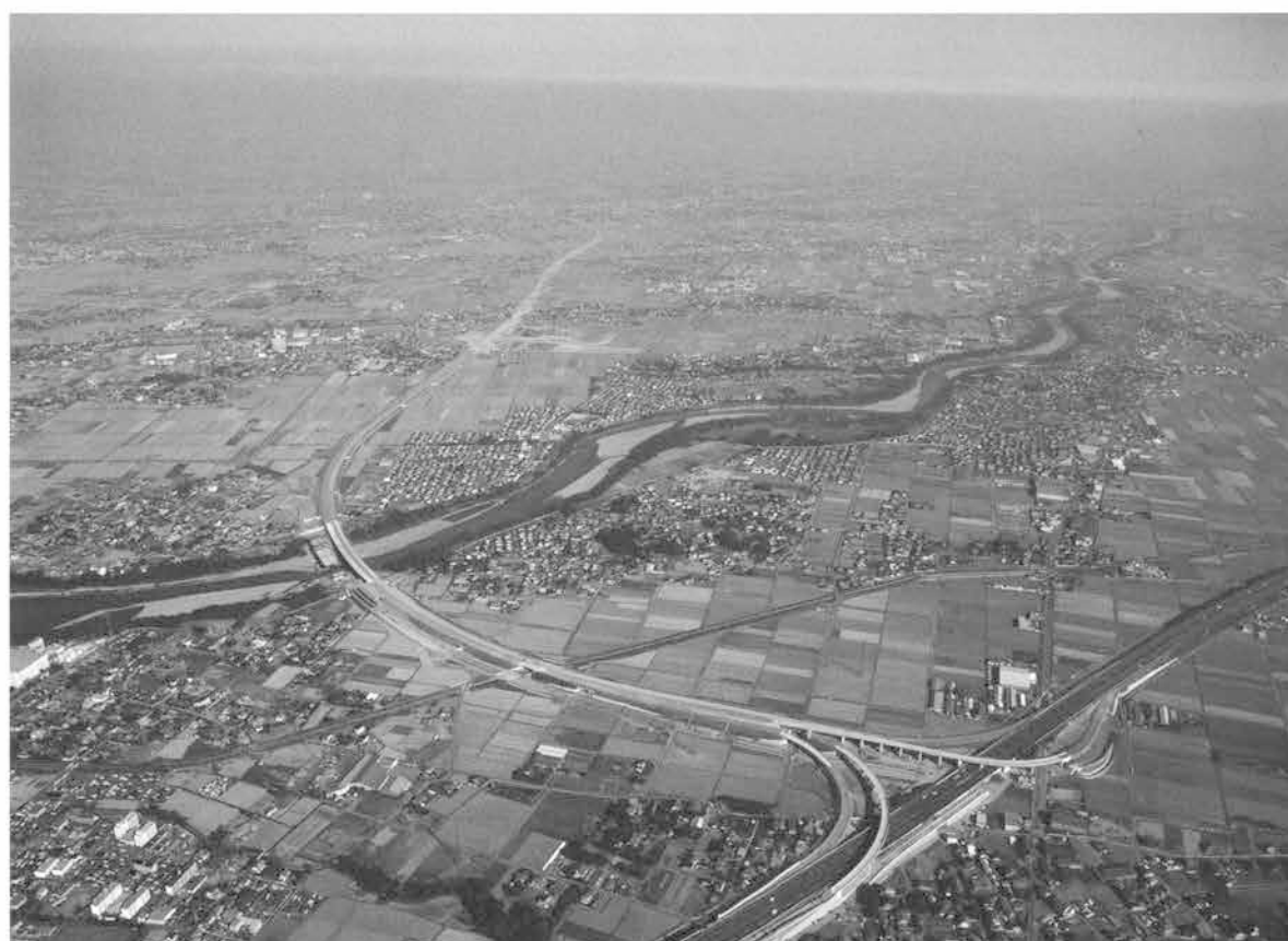
遺跡遠景（高崎J.C.から北関東自動車道を臨む、西から）
