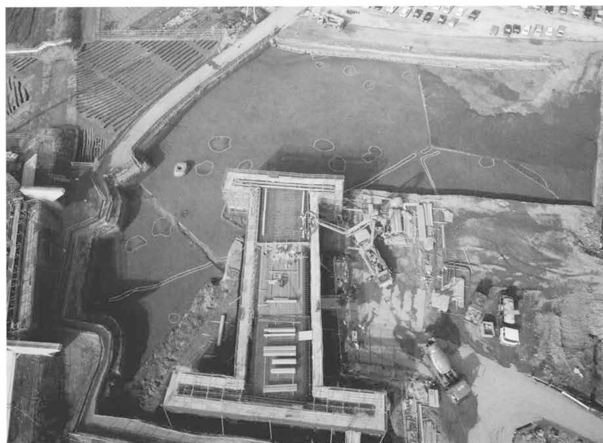
D区全景（上半部は県道調査部分、上が北）
