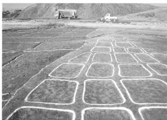
埋没流路東水田面(南から)
