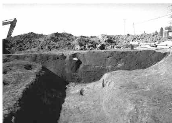
L区9・14号溝(東から)〈1〉
