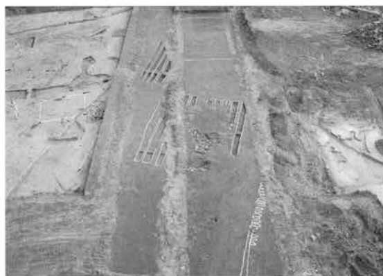
D区現道部分全景（北から）
