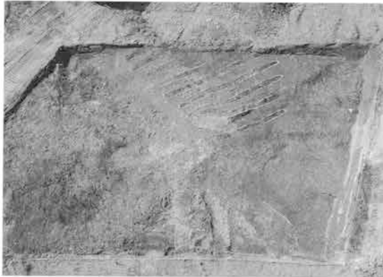
堤防下面（西から）
