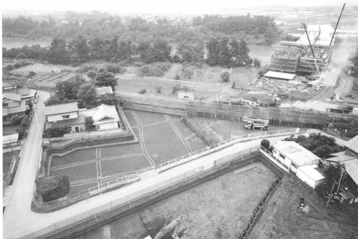
全景（利根川を臨む、北から）
