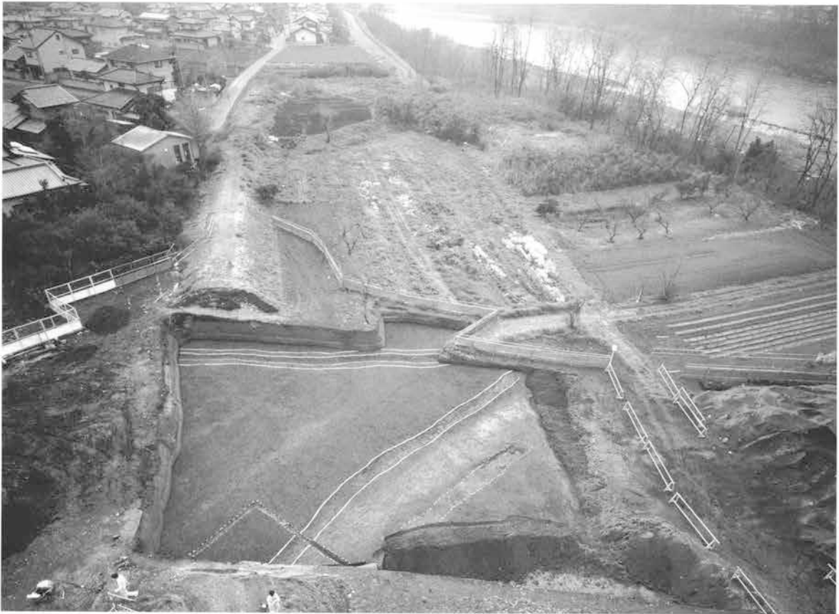
全景（北東から）
