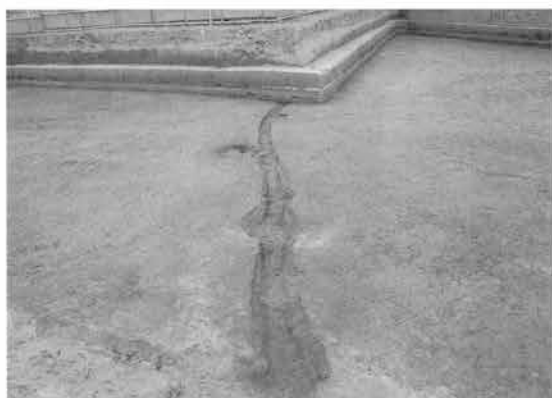
B区7号溝 (北から)
