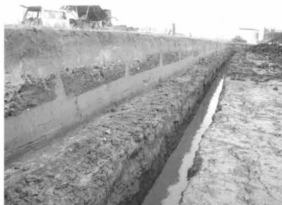
1号土坑群セクション(西から)
