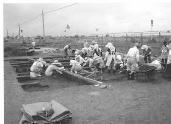
2号土坑群調査風景（東から）
