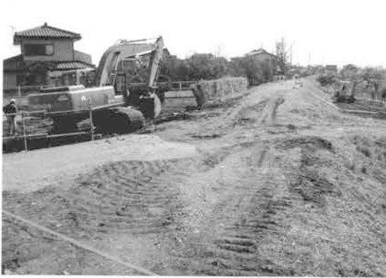
堤防除去作業（西から）
