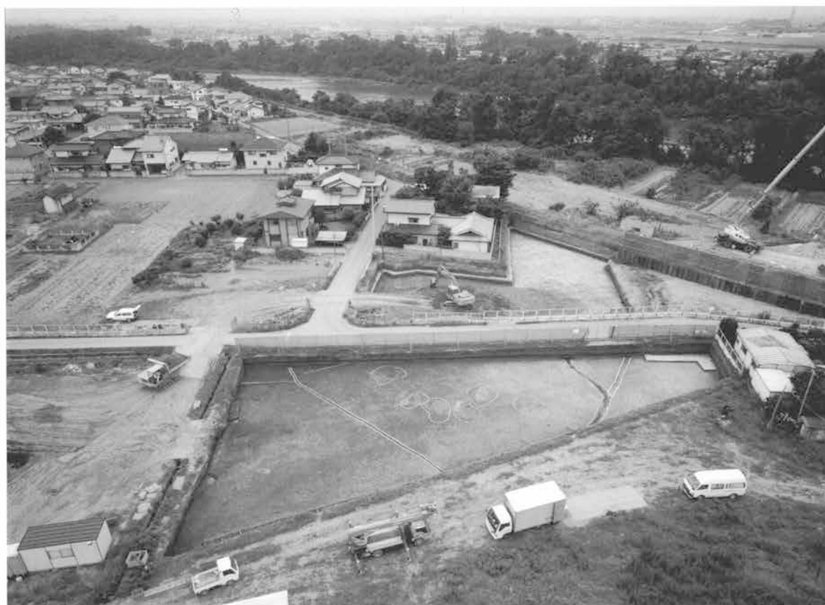
C区全景（後方は利根川、北から）
