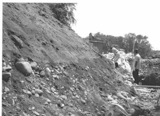
土層断面（礫層上部にAs-A軽石、東から）
