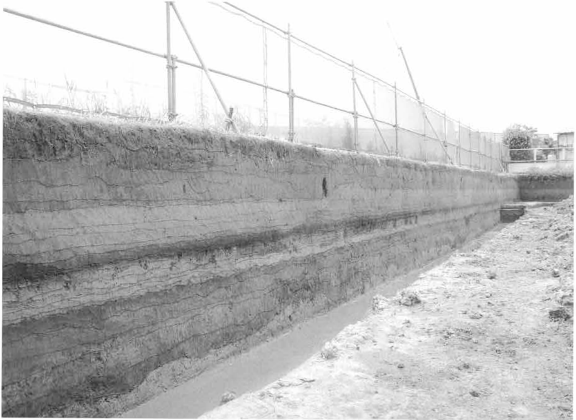
C区南壁（北東から）
