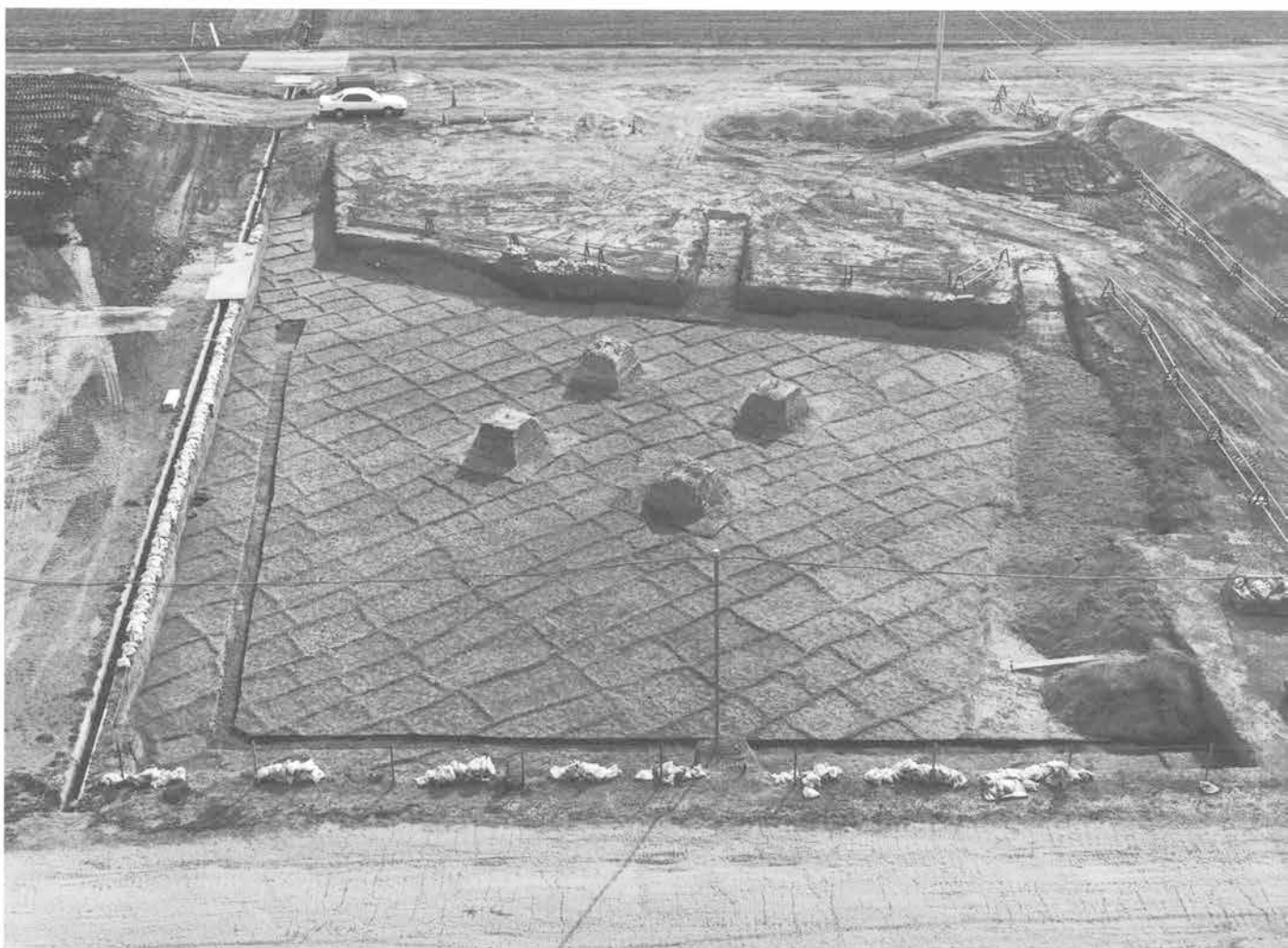
2. C区北西端 (鉄塔部分) 全景 (西から)
