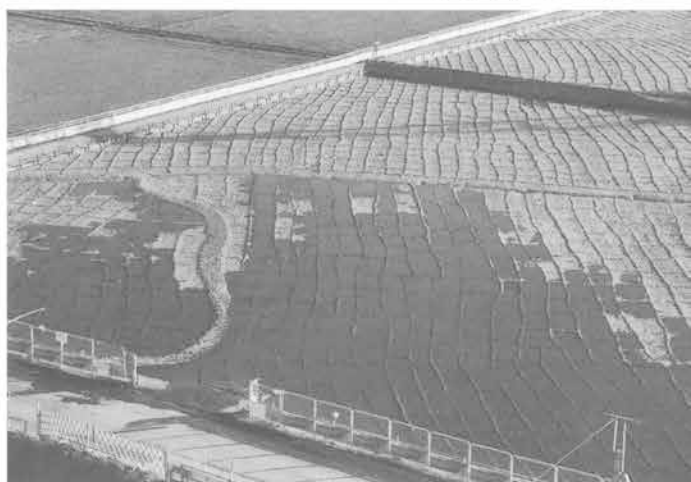
2. 給水実験 (北西から) 黒色部分が水
