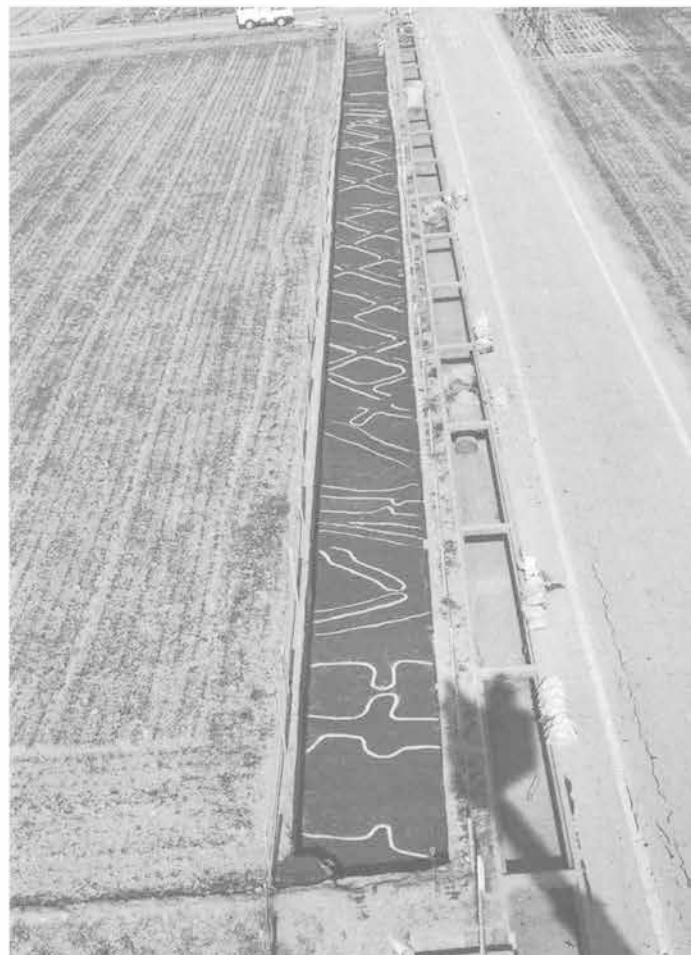
6. Aランプ B区平行部分 (南から)
