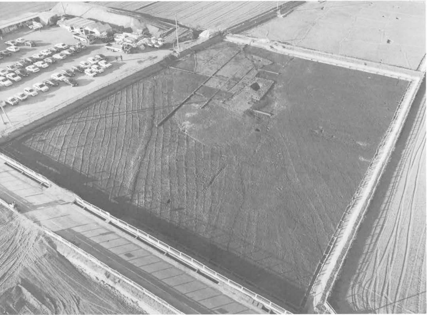
1. E区全景 (南東から)
