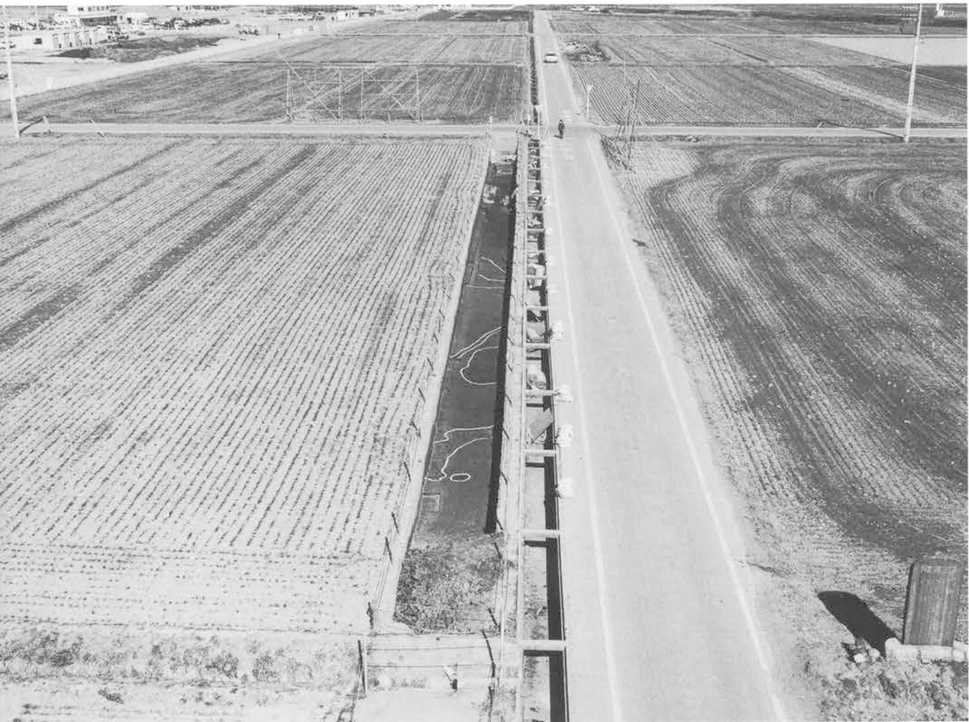
1. Aランプ B区平行 (南から)
