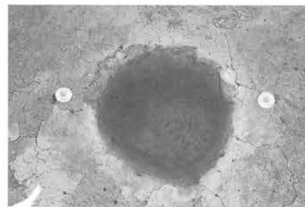
2号杭列 P-4 (北から)
