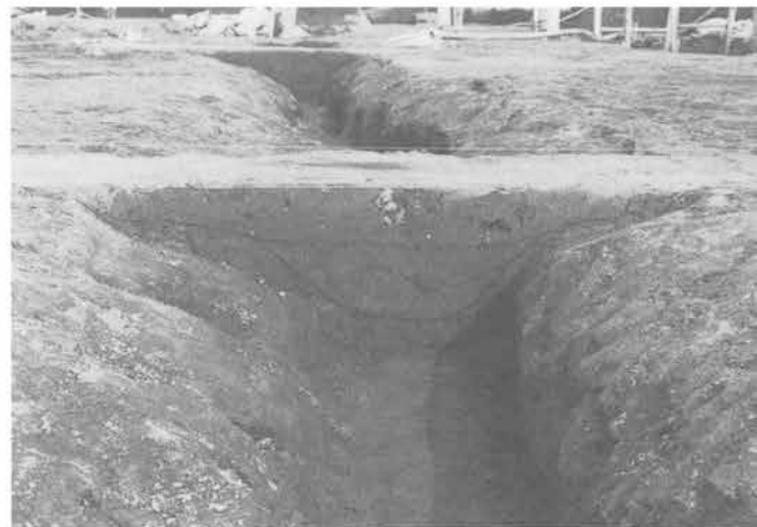
7. 256号溝 第242図SH (西から)
