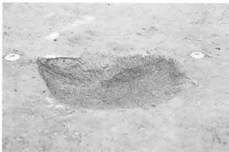
2号杭列 P-5セクション(南から)
