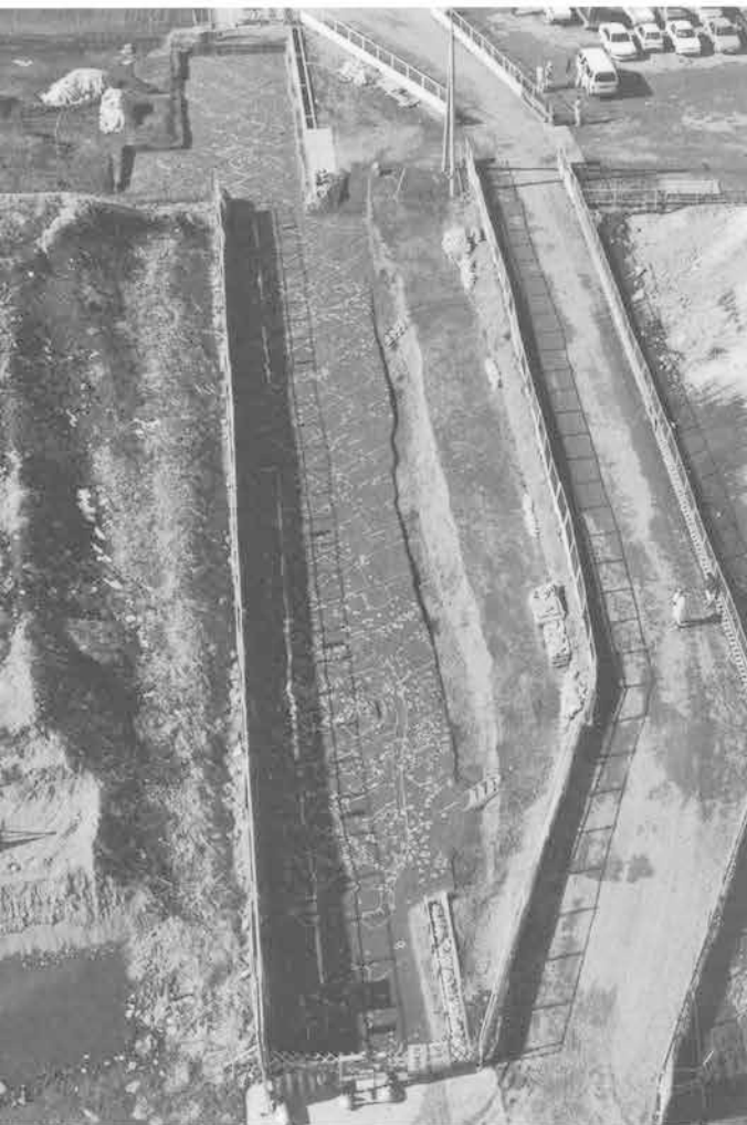
2. D・E区中間部分 (東から)
