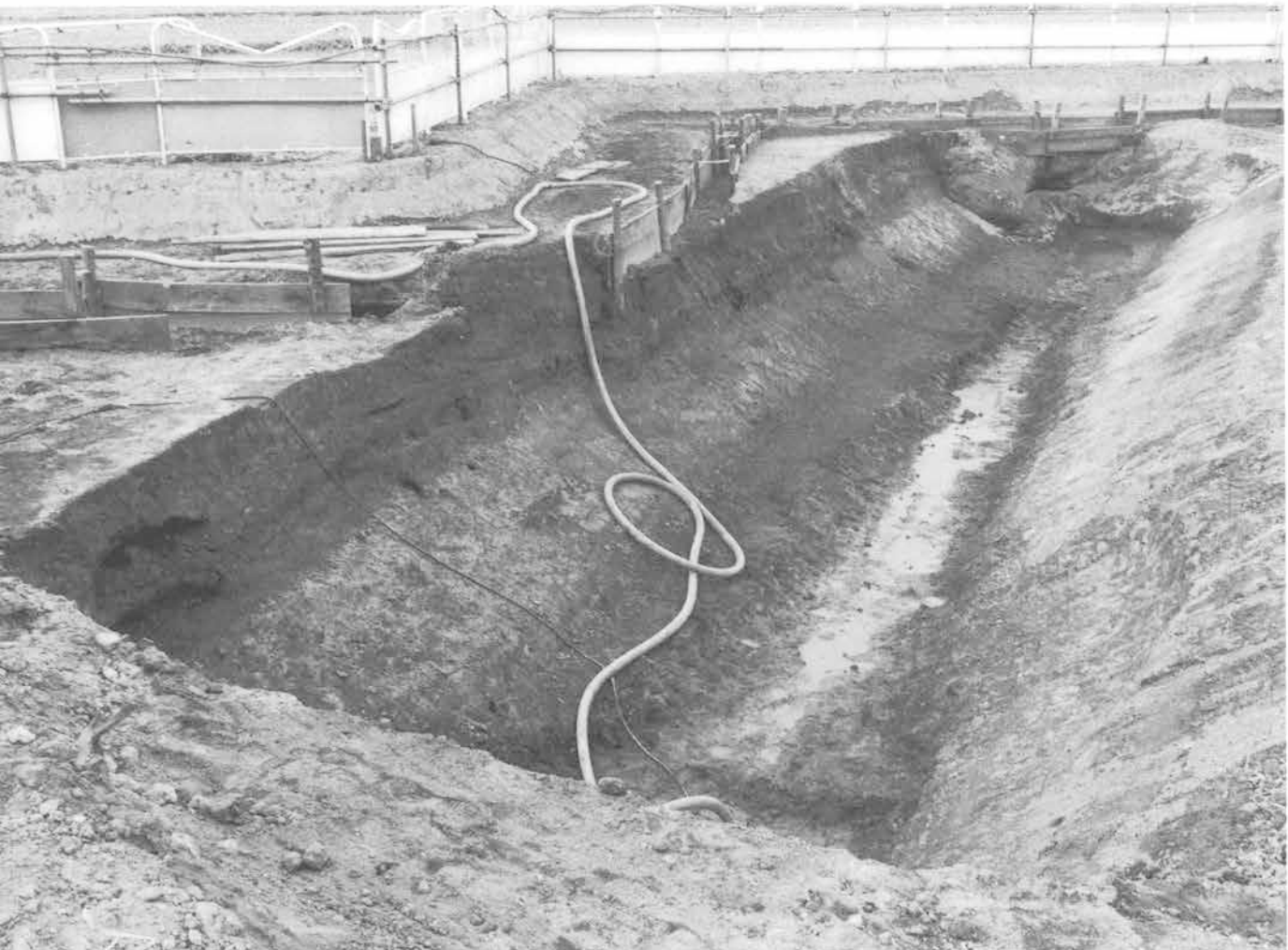
2. 大溝 (幹線用排水路) C区部分 (南から)
