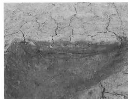
18号杭列P-4セクション (南から)
