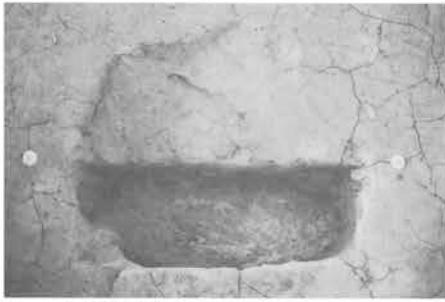
5号杭列 P-6 (南から)
