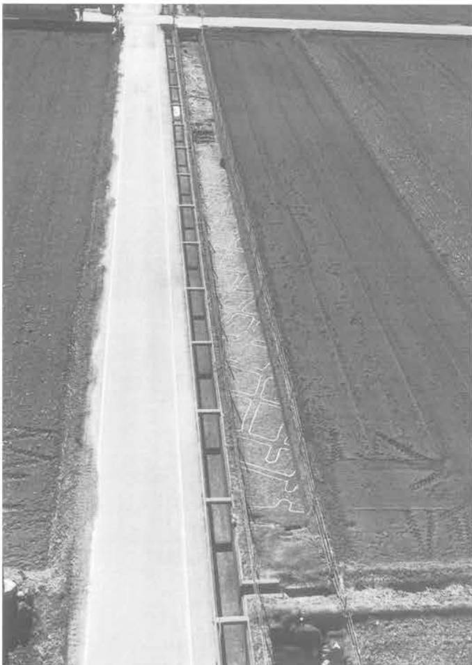
5. Aランプ A-2区平行部分 (南から)
