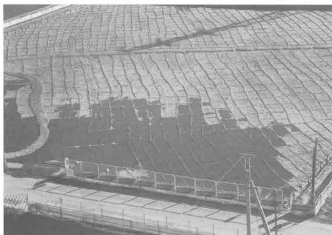
1. 給水実験 (北から) 黒色部分が水
