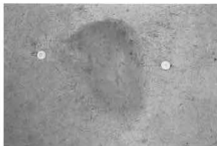
6号杭列 P-2 (南から)
