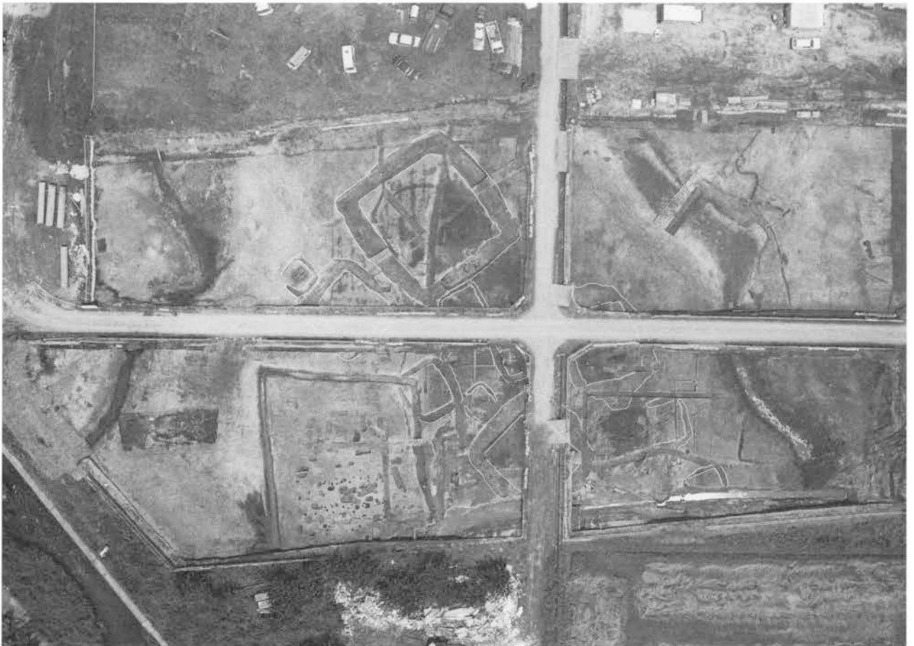
1. I・II区As-C下谷全景航空写真(南から)
