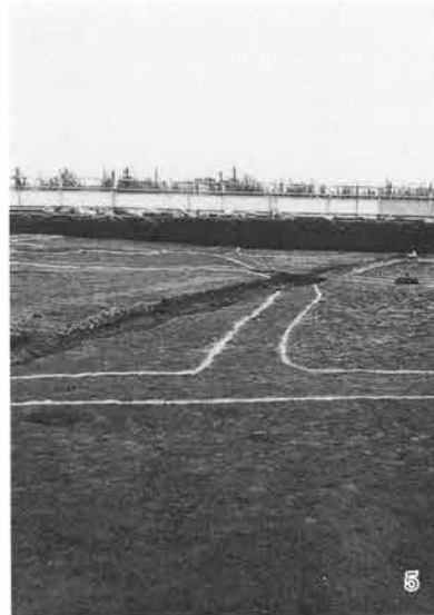
D区 水田3号畦 (南から)
