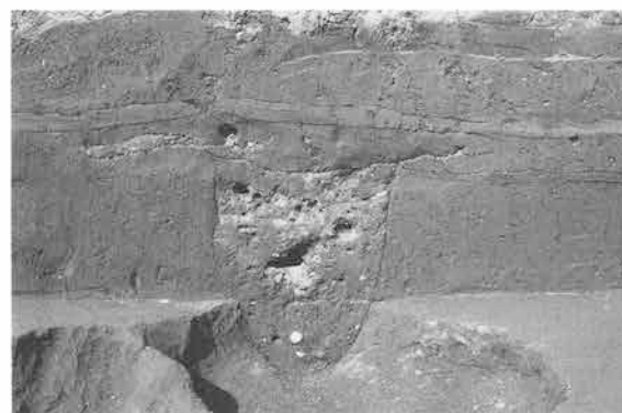
8 A-7 土坑断面 (南東より)
