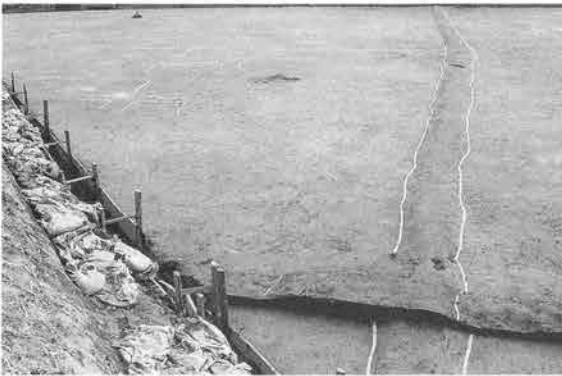
2 D6—1大畦 (北西より)
