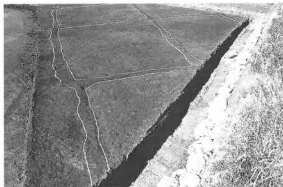
4 As—C混土水田E区北部 As—C混土層除去状態（南東より）
