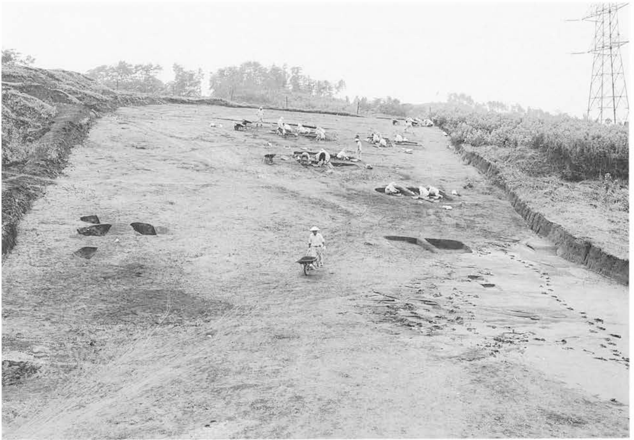
作業風景（東より）
