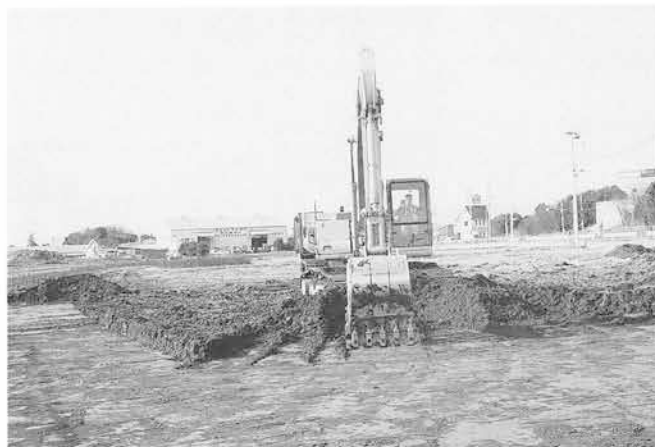
1面表土掘削（東より）
