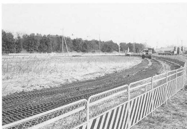
1面表土掘削（西より）
