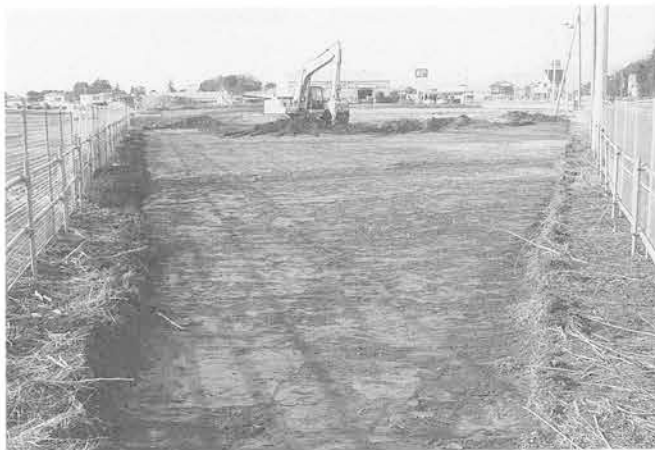
1面表土掘削（東より）
