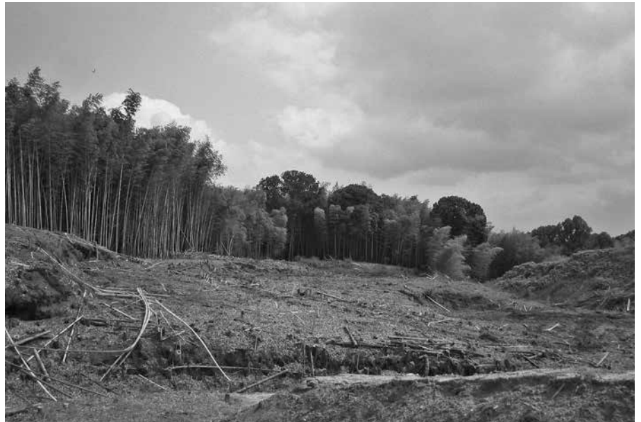
(2) A地区伐採後遠景(南から)
