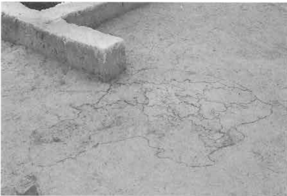
3. 土壤攪乱確認状況 (5-10・30G)
