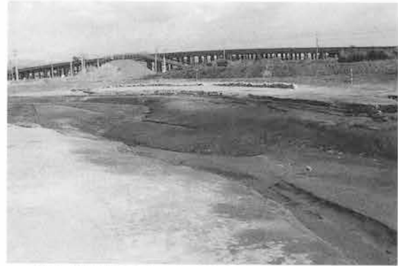
第1号堀第3面 (南西より)
