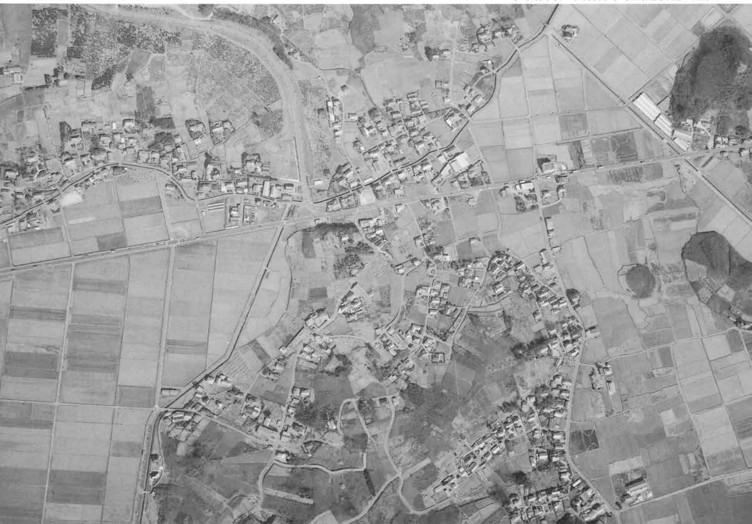
下 太田堰・大谷分水堰周辺状況（垂直）
