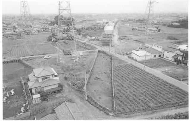
奈良・平安時代(泥流上面) 1次本線調査全景(斜め 西→)
