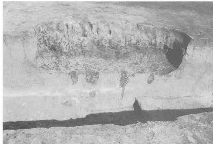
d. 同左・半断面の状況
