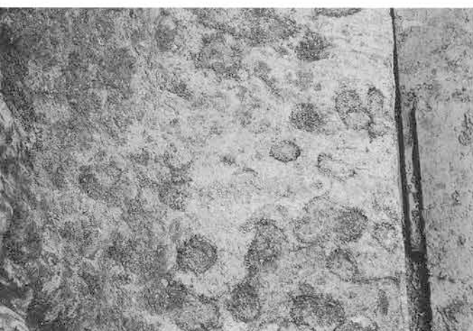
g. 同上・底面の状況
