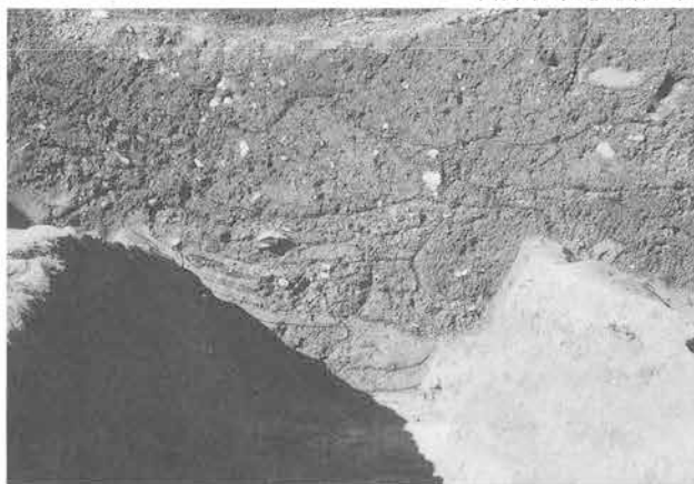
西壁断面（東から）
