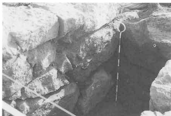
11号古墳石室東壁の状況 西→
