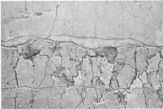
21号溝跡土層断面 北東→
