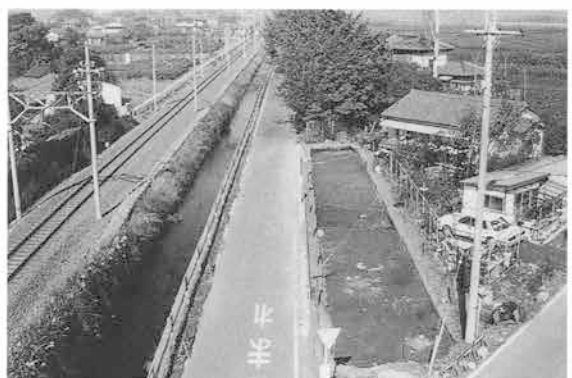
H18区の調査区全景 南東→
