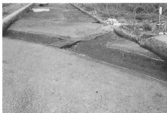
5号溝跡近景 南東→
