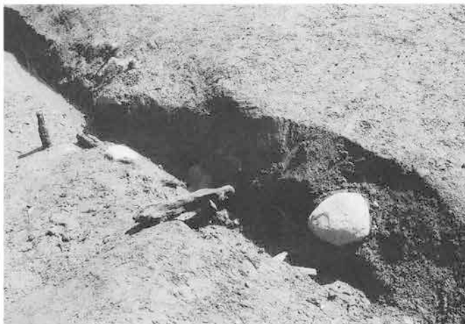
2 同1 水口の杭と堰板
