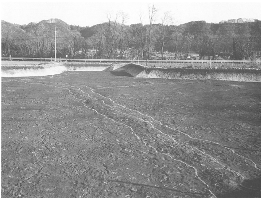
6-Eブロック全景 (西から)
