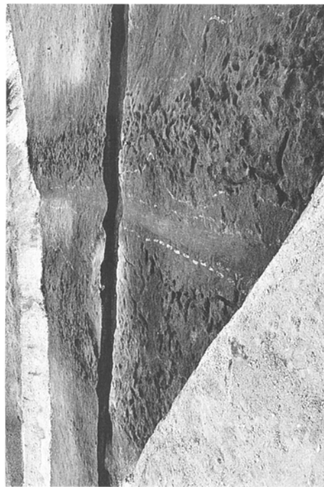
2号・3号畦、1号畦 (FP混じり土除去後の様子) (北から)
