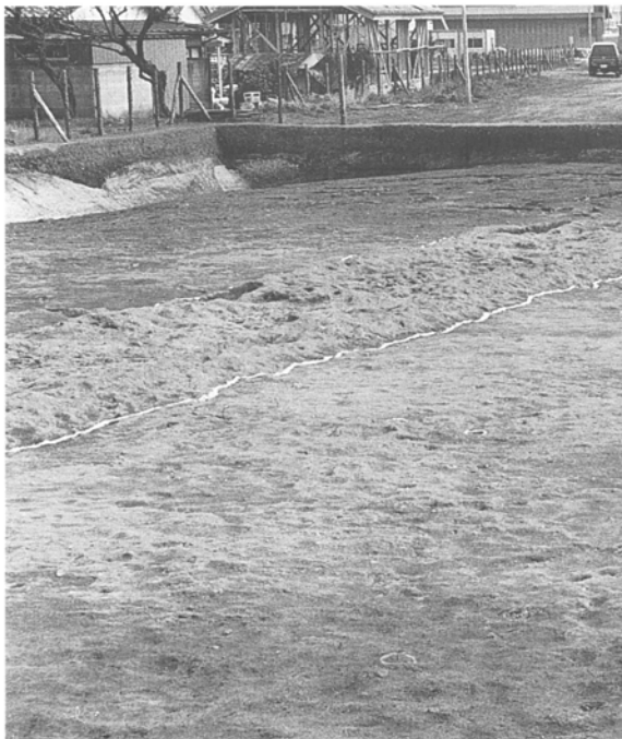
3-Bブロック全景 (北から)
