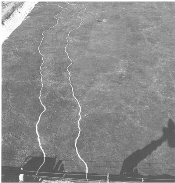
4-Dブロック全景 (南から)
