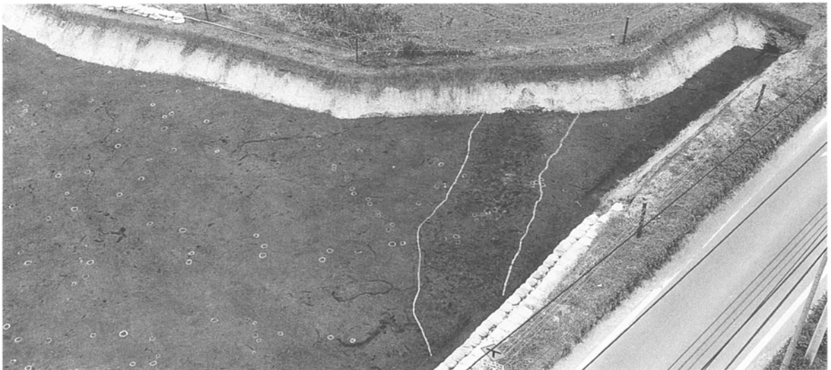
2-Aブロック全景（南西から）
