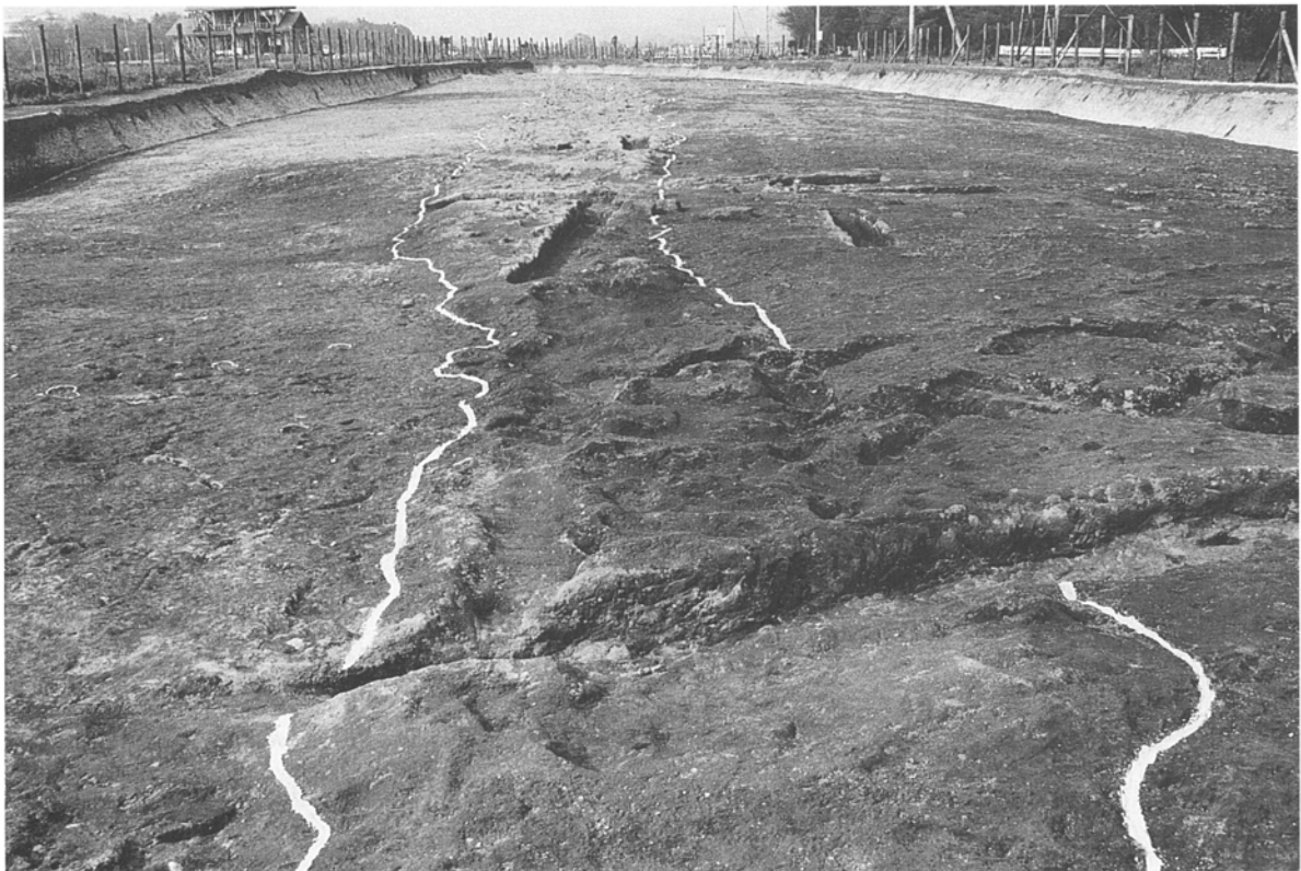
3-Aブロック全景 (南から)
