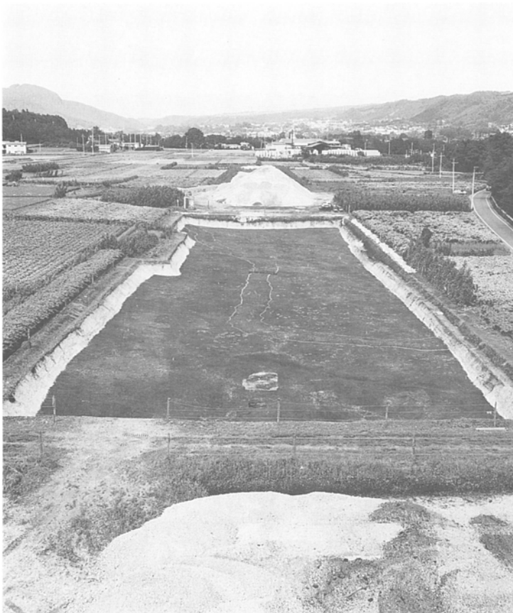
北中道5区全景（南から）
