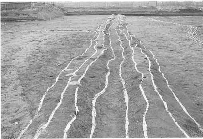
IV区2面中央水路
