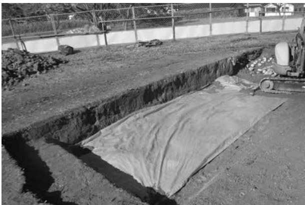
77 11 トレンチ転落石養生 (下は山砂と土囊)
