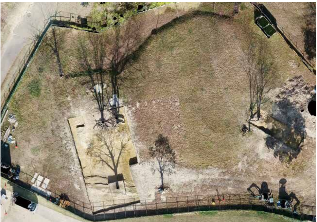
9・10 トレンチ完掘状況
