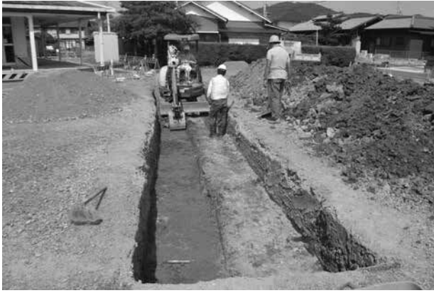
10 18トレンチ 掘削状況（西から）
