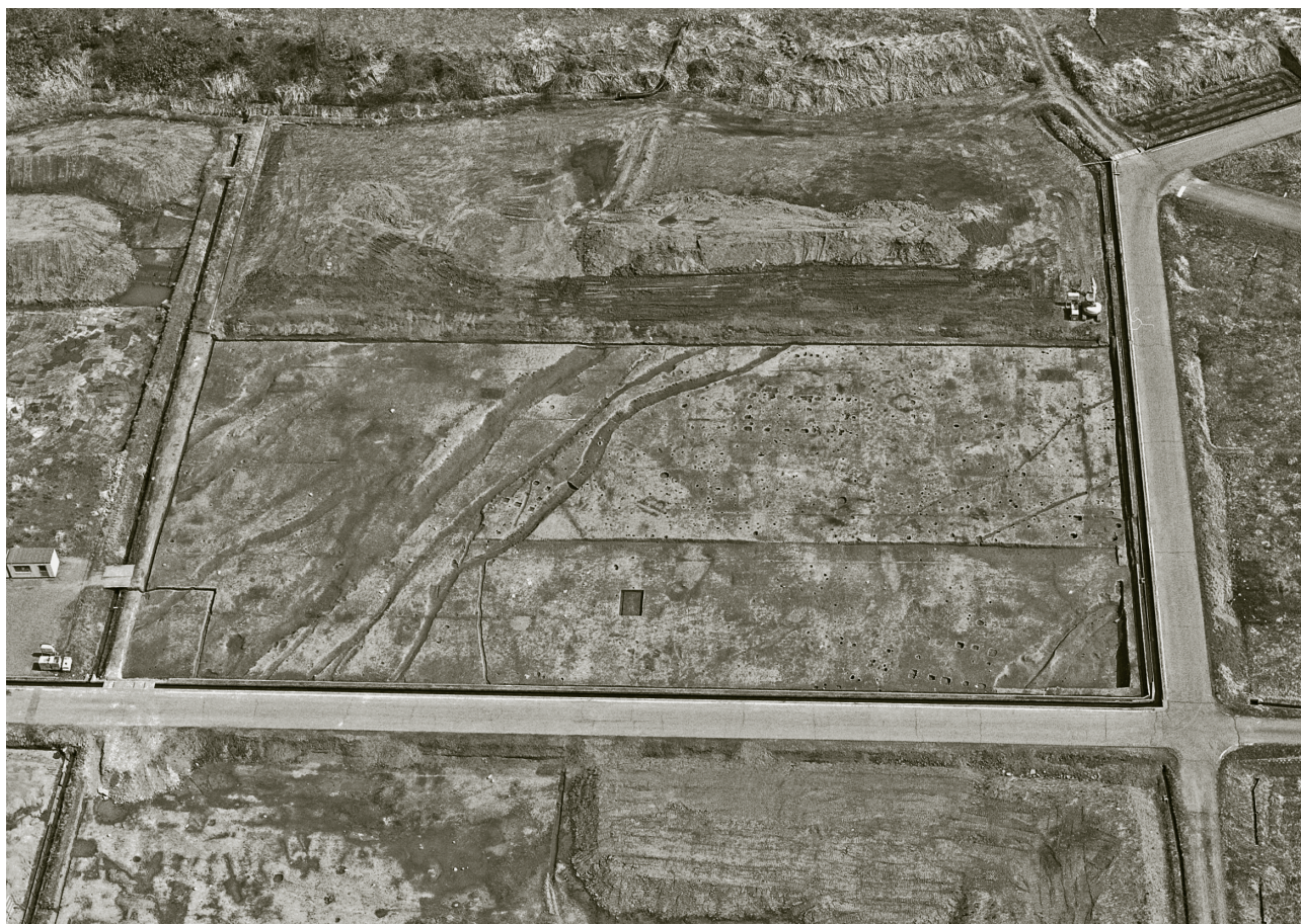
(2) 7区全景 (西方より)
