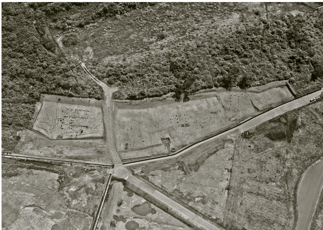
(2) 14・15区全景 (西方より)
