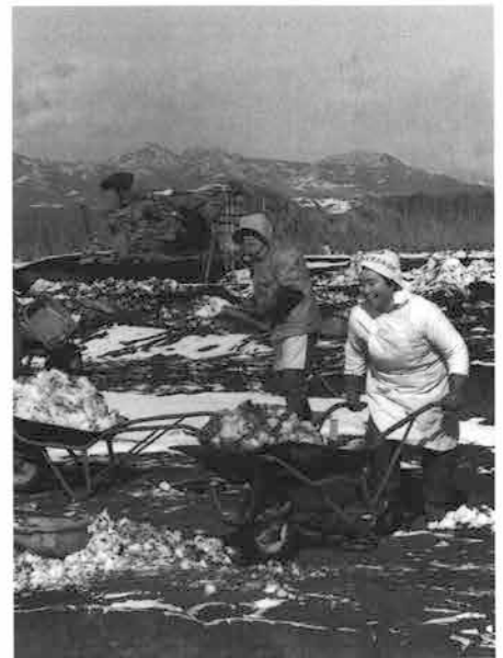
現場の除雪作業
