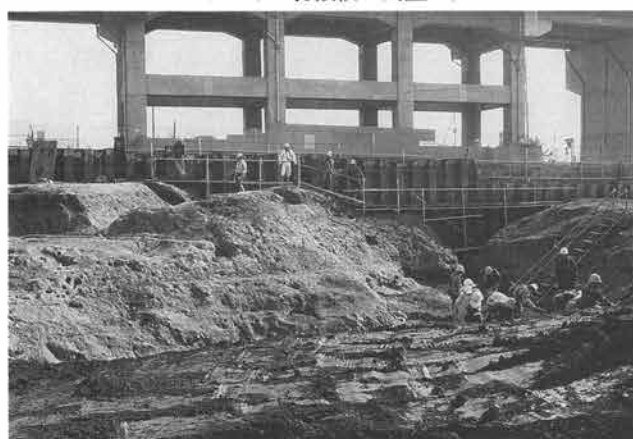
シートパイル打設後の調査状況
