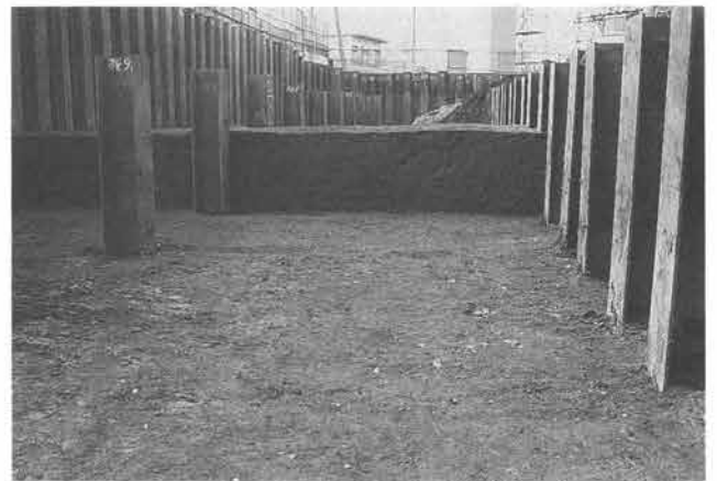
シートパイル施工状況（完掘後）
