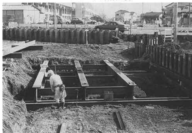
土砂搬出路架橋状況
