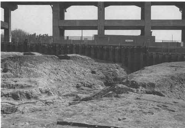
シートパイル施工状況（完掘後）
