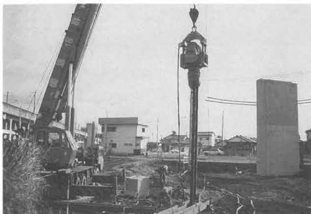
シートパイル打設状況
