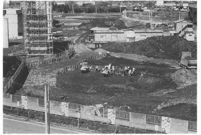
打設完了後調査着手状況
