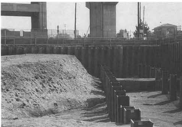
シートパイル施工状況（完掘後）
