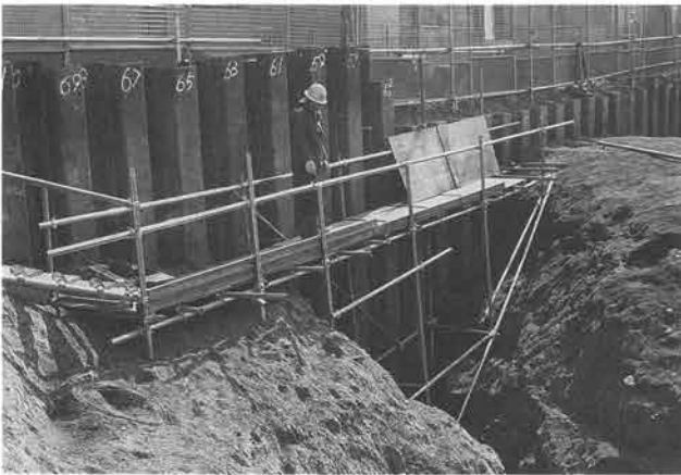
中世掘上通路架橋状況
