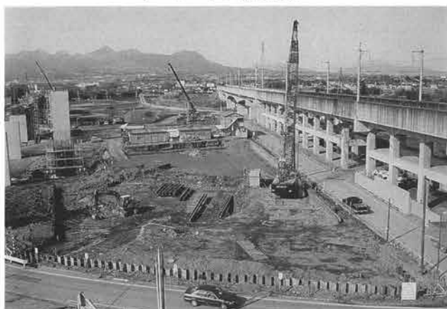
シートパイル打設状況
