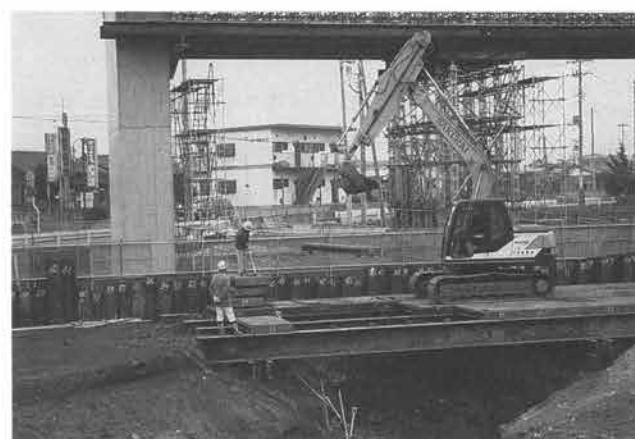
搬出路橋下の掘削状況
