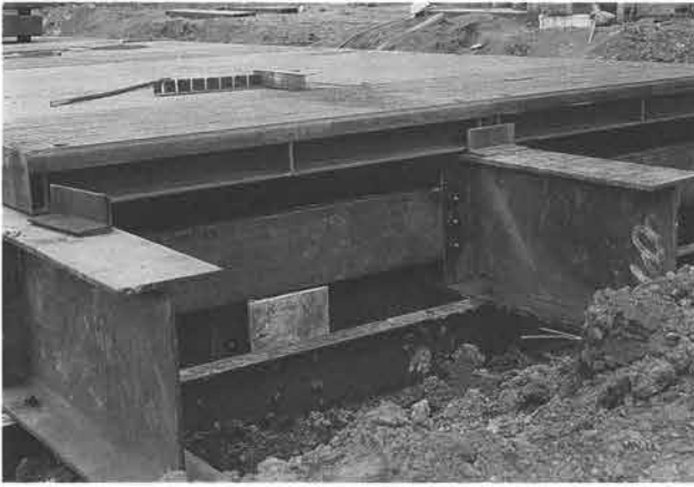
土砂搬出路橋の構造
