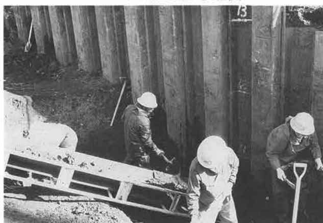
シートパイル打設後の調査状況
