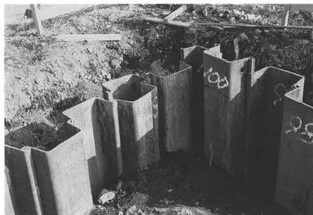
シートパイル屈曲部
