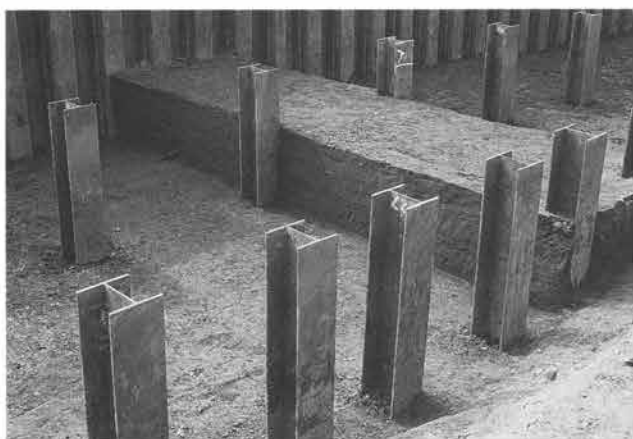
タイロッド施工状況（完掘後）
