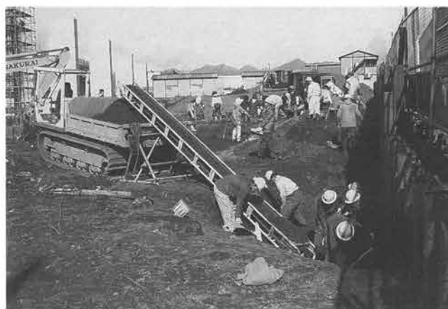
シートパイル打設後の調査状況
