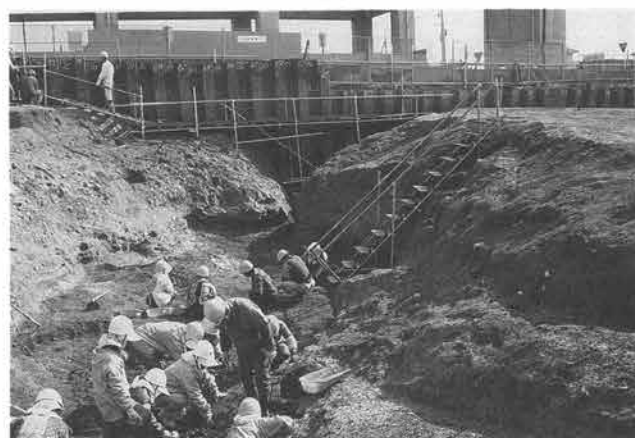
シートパイル打設後の調査状況
