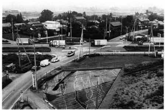
3区側より観音寺を見る 霞む遠景の前の木立中 南西→
