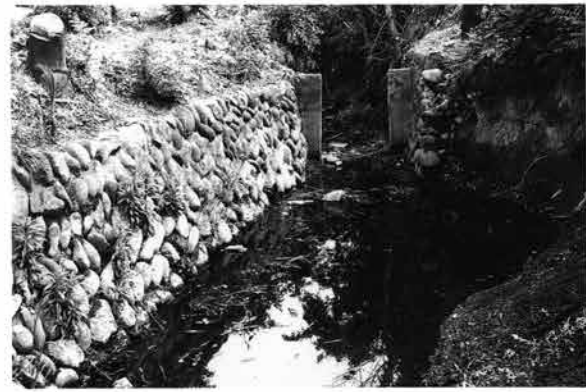
同左くるま川堰門
