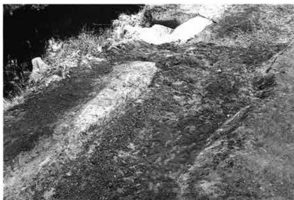
同上と築堤跡上面
