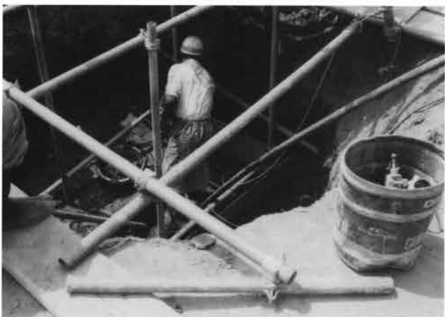
AY-5号井戸調査風景
