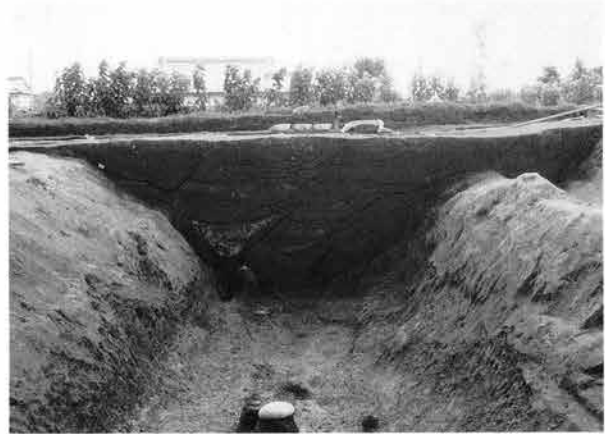
4号溝南端部セクション (北より)
